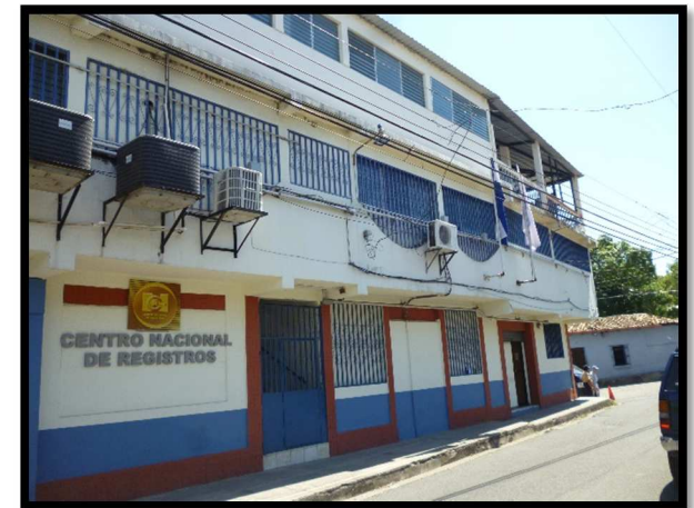
Foto N°5. Actuales Oficinas del CNR en Barrio San Antonio, Final 4ª Calle Poniente Fuente: Elaboración Propia
