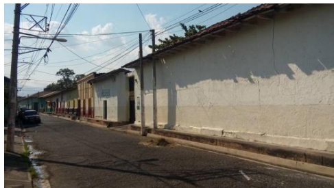
Imagen 37: Acceso sobre la 12ª Calle Oriente.
