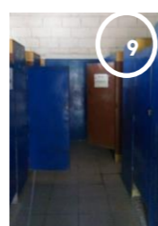
9. Vista exterior e interior de servicios sanitarios
