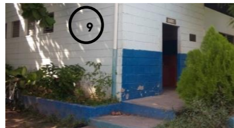
9. Vista exterior de servicios sanitarios
