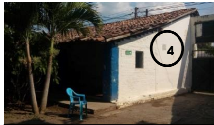
4. Vista exterior de bodega
