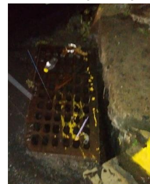
Imagen 34: Vista de tragante (aguas lluvias)
