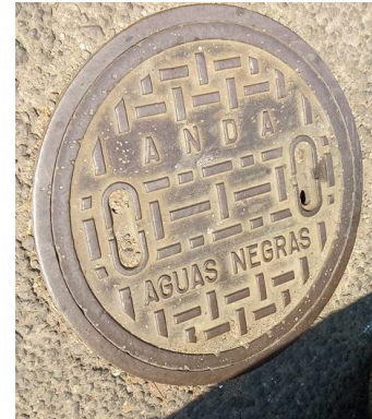
Imagen 32: Pozo de aguas negras sobre la 12ª Calle Oriente
