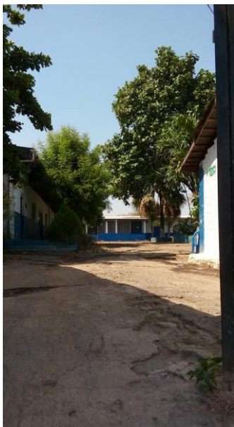
Imagen 25: Vista desde el portón de acceso hacia el interior de CFI
