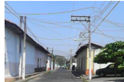
Imagen 33: Vista de infraestructura de servicio eléctrico sobre 12ª Calle Oriente
