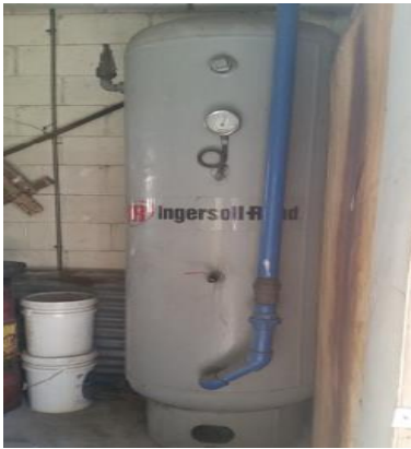
Tanque de aire comprimido
