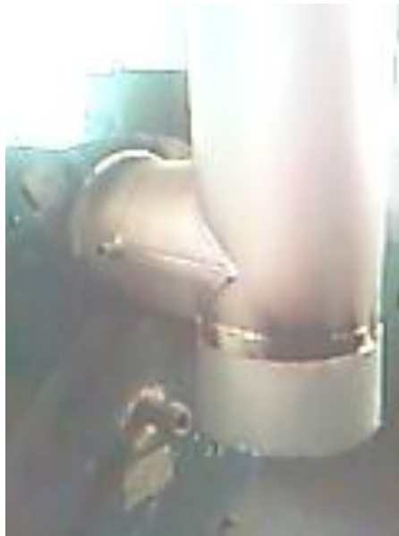
Fotografías 42 y 43. Conexión de chimenea a tapadera trasera de caldera No 1
