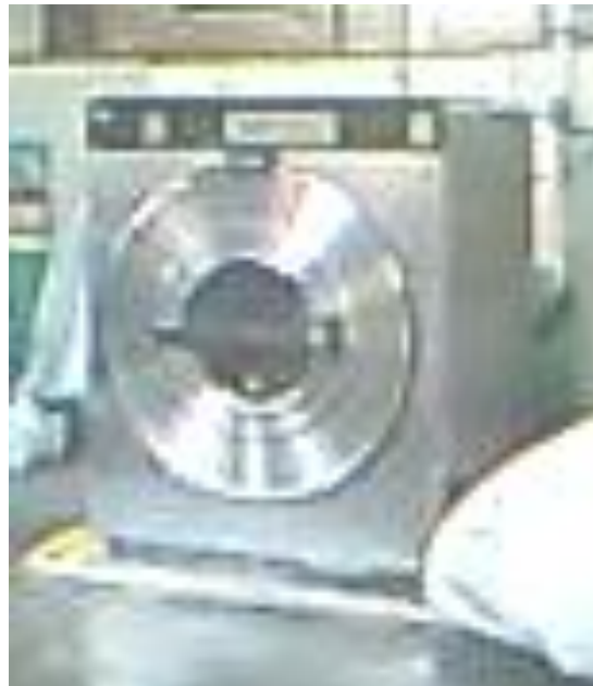
Fotografía 6. Una de las lavadoras extractoras automáticas marca Girbau. Estas lavadoras son conocidas como la No.1 y No.2. La No.1 se encuentra en mal estado
