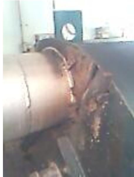
Fotografías 42 y 43. Conexión de chimenea a tapadera trasera de caldera No 1
