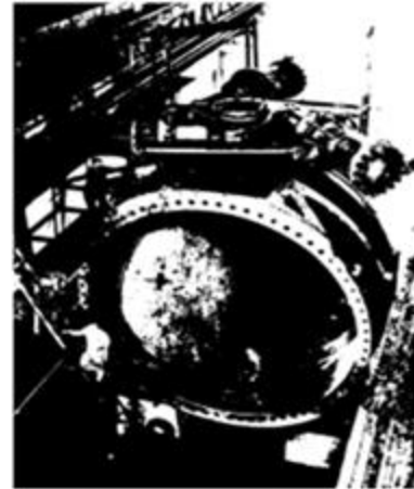
(b) compuerta válvula de mariposa
