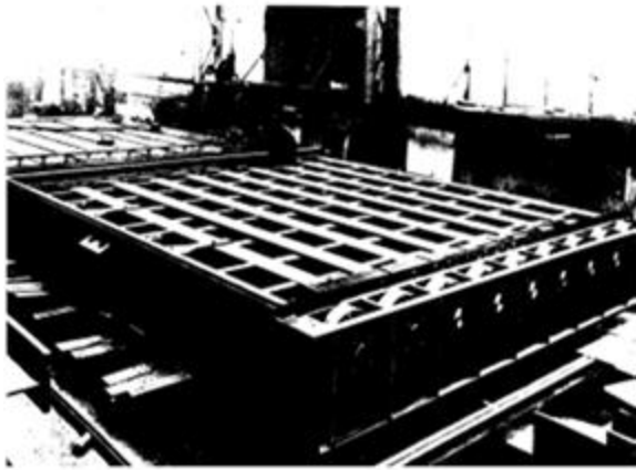
(a) compuerta de rodillos
