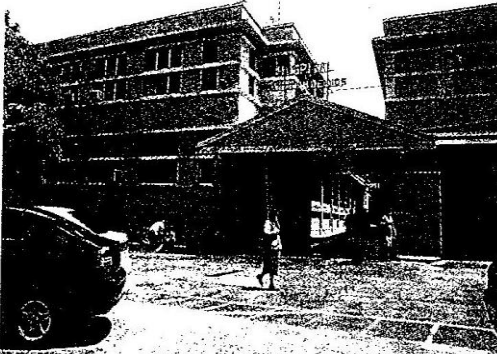
Sin fondos. Fachada del Hospital San Juan de Dios de Santa Ana, el cual hizo compras sin tener presupuesto para ello en 2005.
