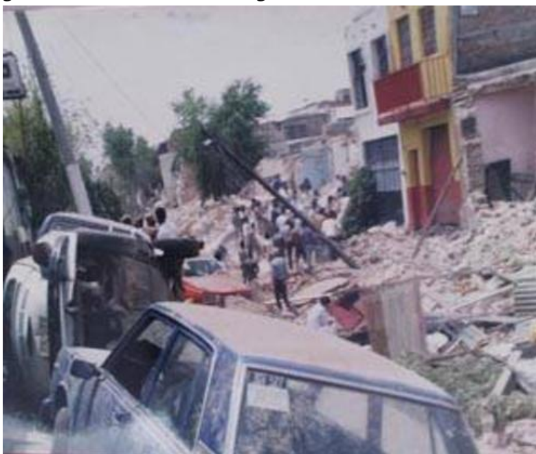
Fig. 1.2. Foto de los daños causados en el barrio céntrico de Guadalajara, el 22 de abril de 1992 durante la explosión de una alcantarilla.
