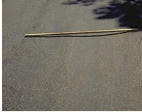
FIGURA 4.2 – Ahuellamiento
