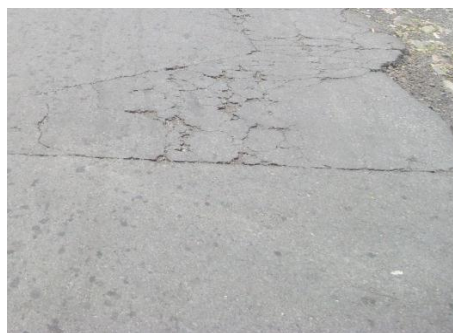
FIGURA 4.5 – Fisura Transversal
