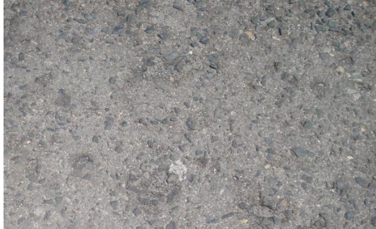
FIGURA – 4.4 Peladura
