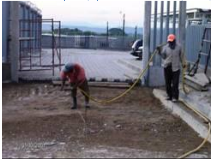
Ilustración 22 - Trabajadores preparando el suelo subrasante para adoquinar.
