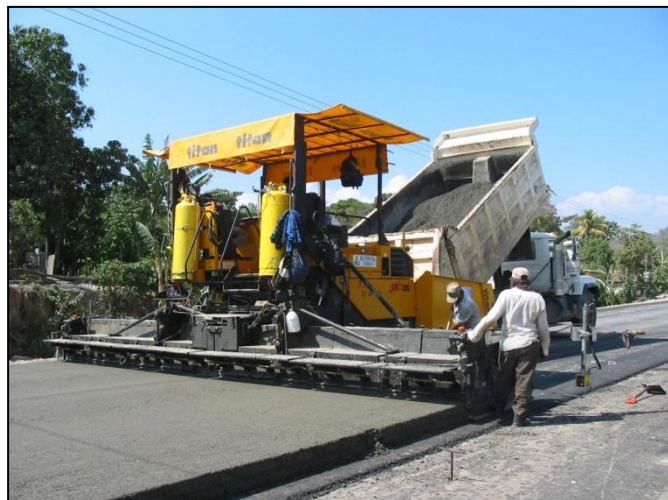
Ilustración 34 - Transporte y colocación del concreto hidráulico.
