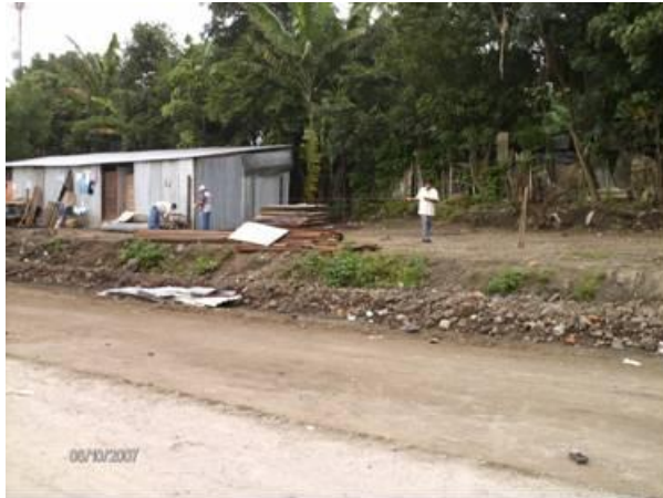
Ilustración 15 - Trabajadores en la tarea de replanteo para la construcción de viviendas
