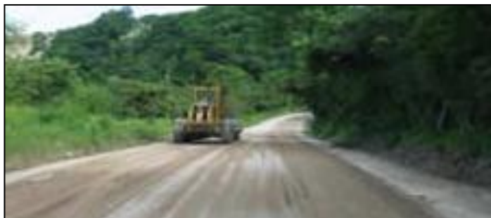
Ilustración 31 - Preparación de la superficie para colocación de CCP.
