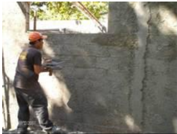
Ilustración 51 - Trabajador en la tarea de azotado de mezcla (repello)
