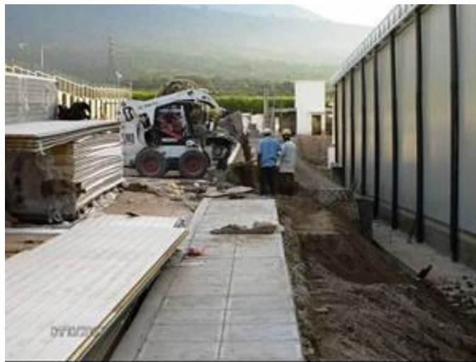
Ilustración 21 - Acera peatonal, relleno y compactación
