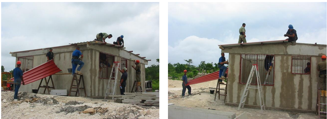
Ilustración 50 - Techado de una estructura
