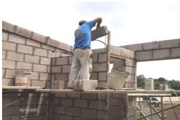
Ilustración 46 - Construcción de paredes de bloque
