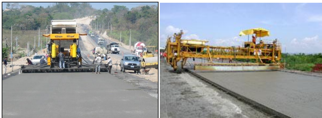
Ilustración 36 - Equipo utilizado para la distribución, conformación y compactación del pavimento.
