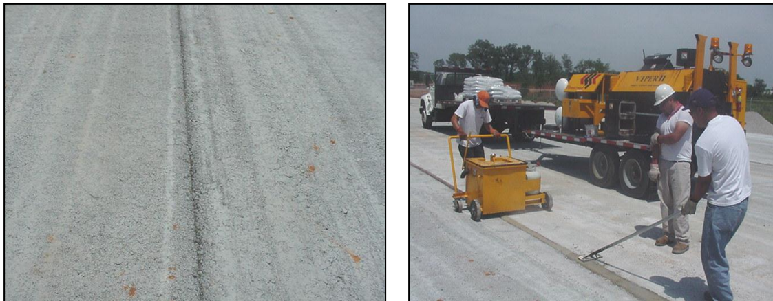
Ilustración 41 - Vista y sellado de Junta fría
