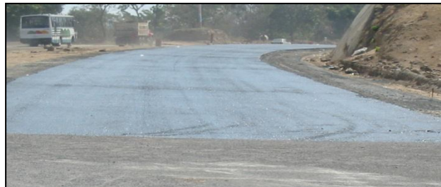
Ilustración 42 - Curado del concreto a través de un mezcla bituminosa
