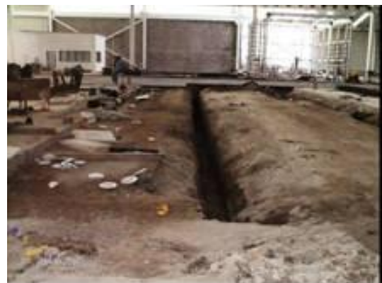
Ilustración 19 - Excavación manual con barra, y Zanjas para empotramiento de tubería.
