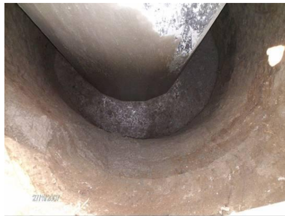
Ilustración 53 - Vista del llenado de una base de torre con concreto
