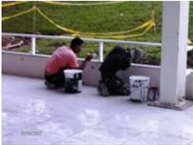
Ilustración 30 - Trabajadores en la tarea de pintura.
