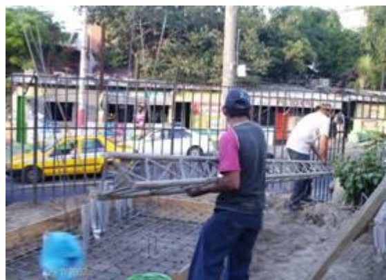
Ilustración 55 - Trabajadores Manipulando el poste Grúa
