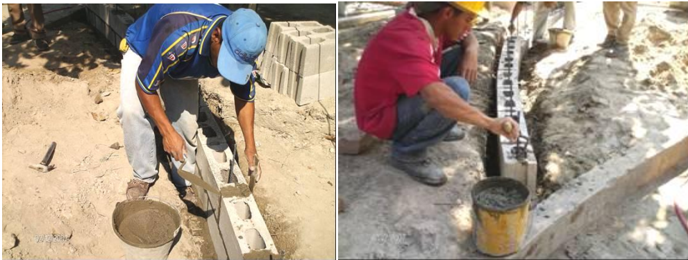
Ilustración 46 - Construcción de paredes de bloque
