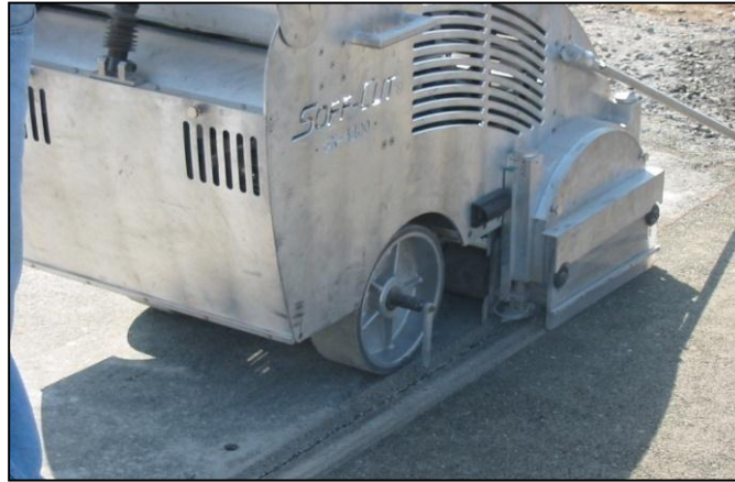
Ilustración 38 - Elaboración de juntas.
