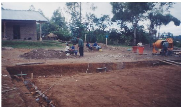
Ilustración 16 - Área de terreno previamente nivelada para construcción de vivienda
