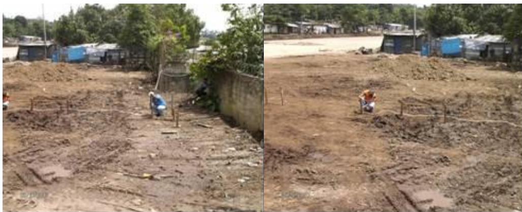
Ilustración 14 - Trabajadores instalando Niveletas para trazo de viviendas.
