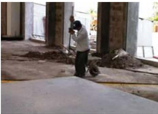
Ilustración 19 - Excavación manual con barra, y Zanjas para empotramiento de tubería.
