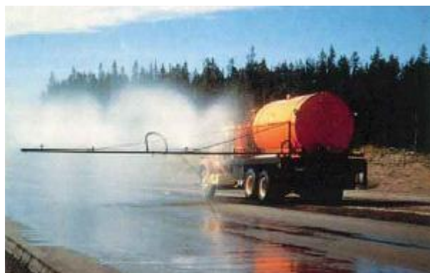
Ilustración 43 - Curado del concreto
