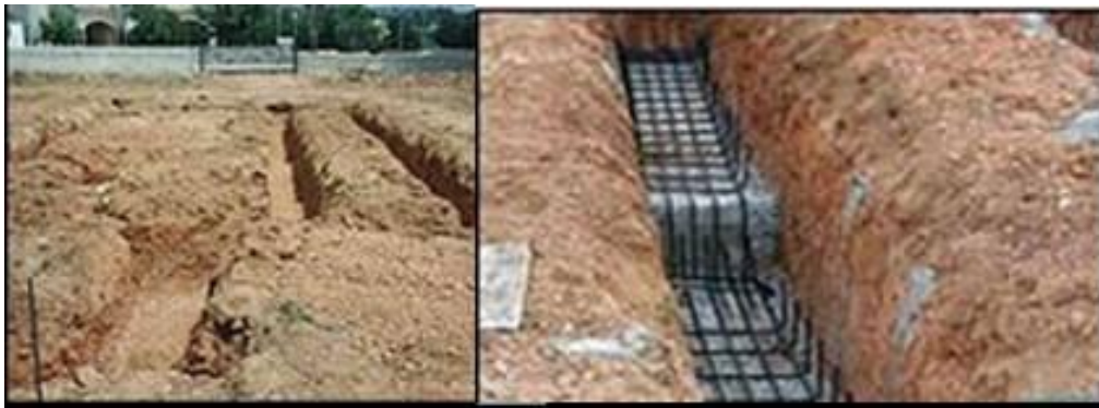
Ilustración 23 - Excavación para solera de fundación.
