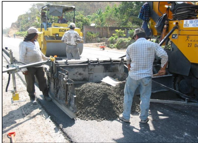
Ilustración 35 - Distribución del concreto.
