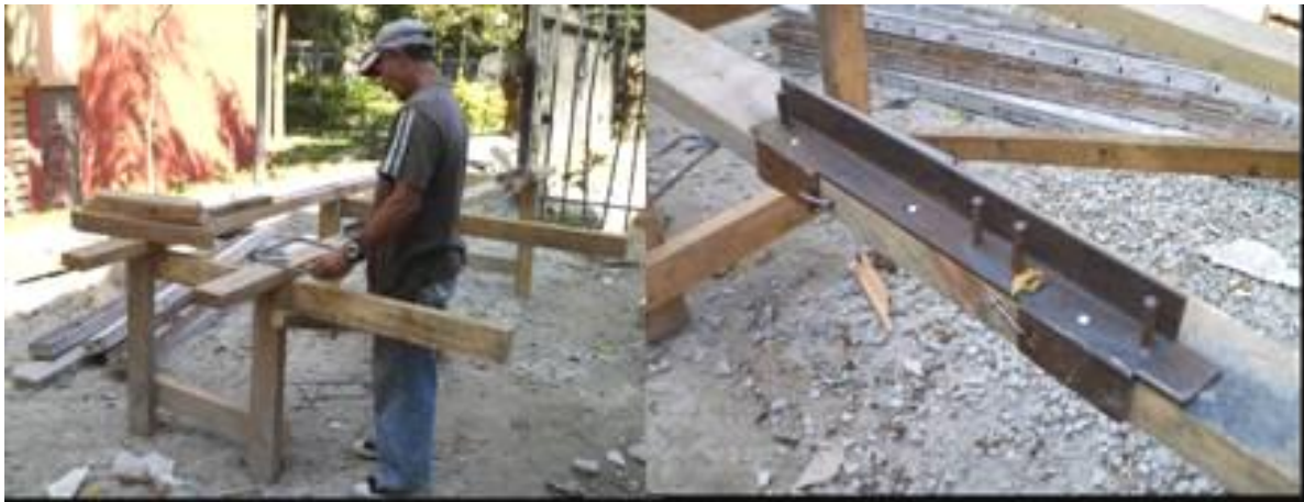
Ilustración 48 - Trabajador verificando la forma de estribos luego de haber doblado en el "trazo"
