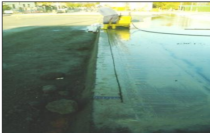
Ilustración 40 - Vista de Junta longitudinal en el pavimento.
