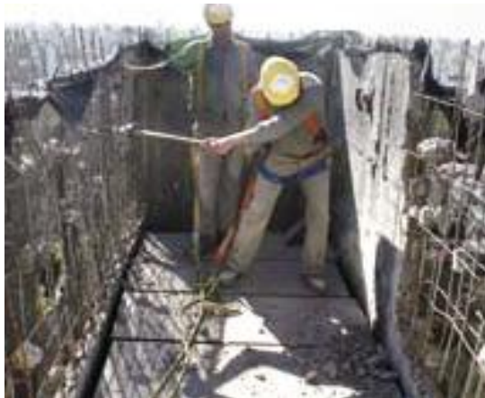
Ilustración 17 - Trabajos de demolición
