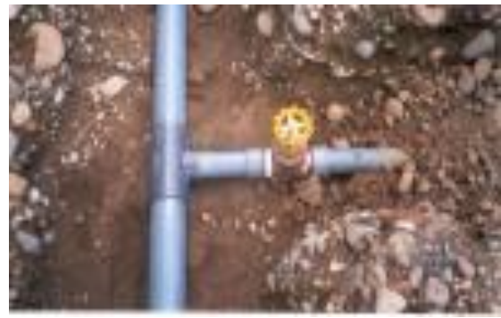
Ilustración 20 - Tuberías subterráneas
