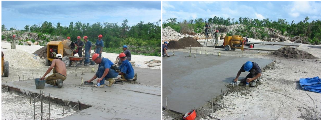
Ilustración 49 - planchado de superficie para piso
