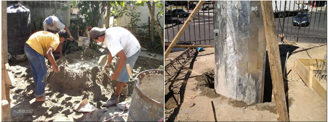
Ilustración 53 - Vista del llenado de una base de torre con concreto
