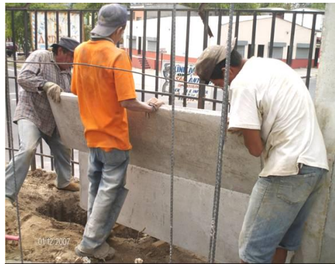
Ilustración 47 - Construcción de paredes prefabricadas
