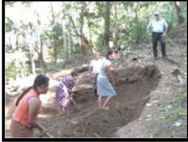
Nivelación de terreno
