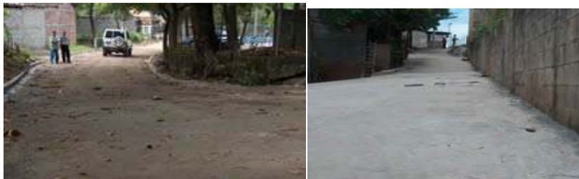
Concreteado y fraguado superficie terminada, en Colonia Vista Hermosa 2
