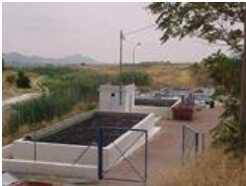
UNIDAD DE TRATAMIENTO DE AGUA
