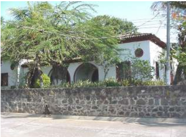
Casa de Habitación entre 7° av. Norte y 3° calle poniente de arcos rebajados y de medio punto.
