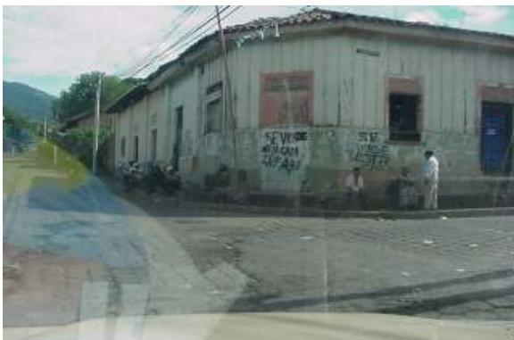
Edificio de valor Histórico sin ninguna protección.
