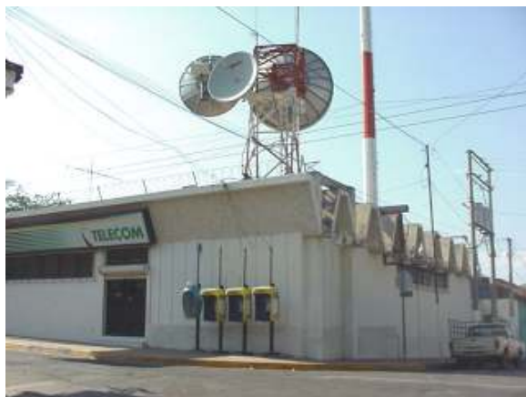
Oficina de telefonía TELECOM
