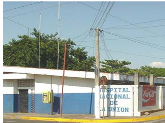
Un postes de alumbrado eléctrico y telefónico.
