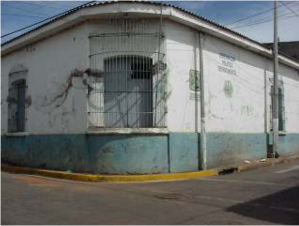
Esquina norponiente de edificio
