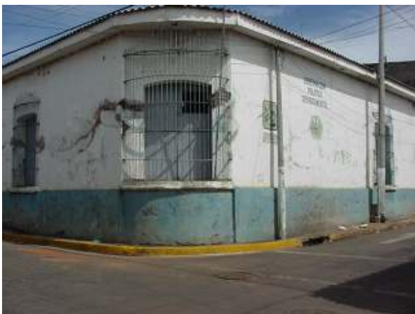
Esquina norponiente de edificio
