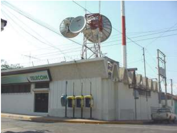
Oficina de telefonía TELECOM
