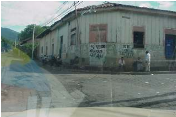
Edificio de valor Histórico sin ninguna protección.
