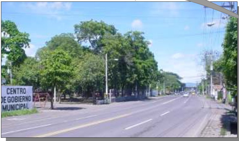
Acometidas de electricidad y telefonía
