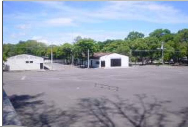
Infraestructura Eléctrica y Telefónica
