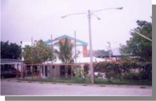
Área exterior de Edificio Administrativo
