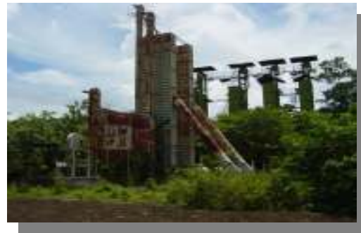
aquí podemos observar las maquinas que procesaban el café y además los silos de almacenaje
