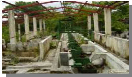
Esta edificación anteriormente era utilizada para despulpar el café y luego pasar por un proceso para su secado.
