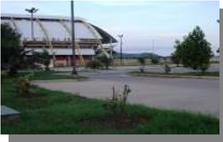
Fachada ppal. De edificio de gimnasio
