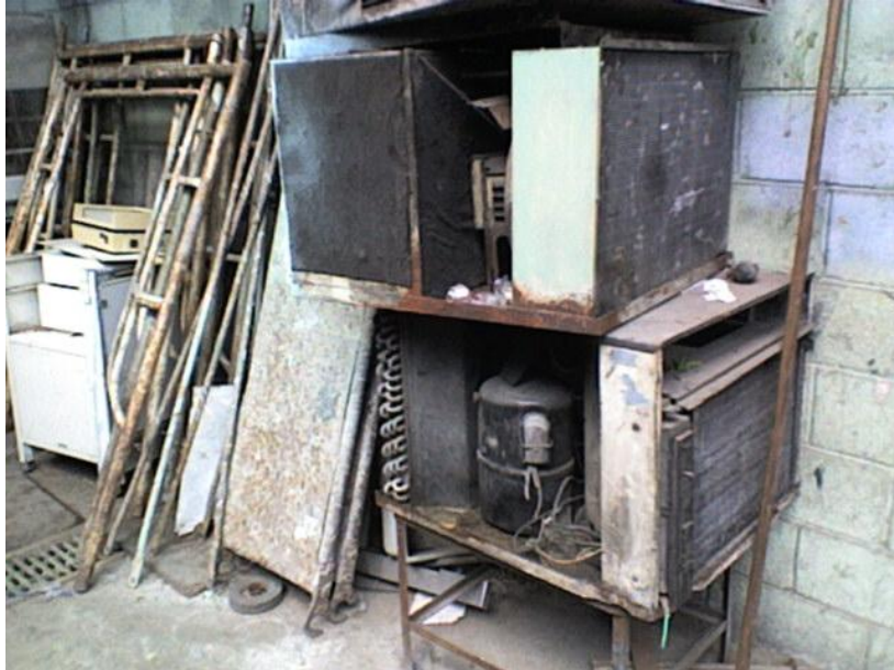
Figura 10 Instalaciones de Talleres.
