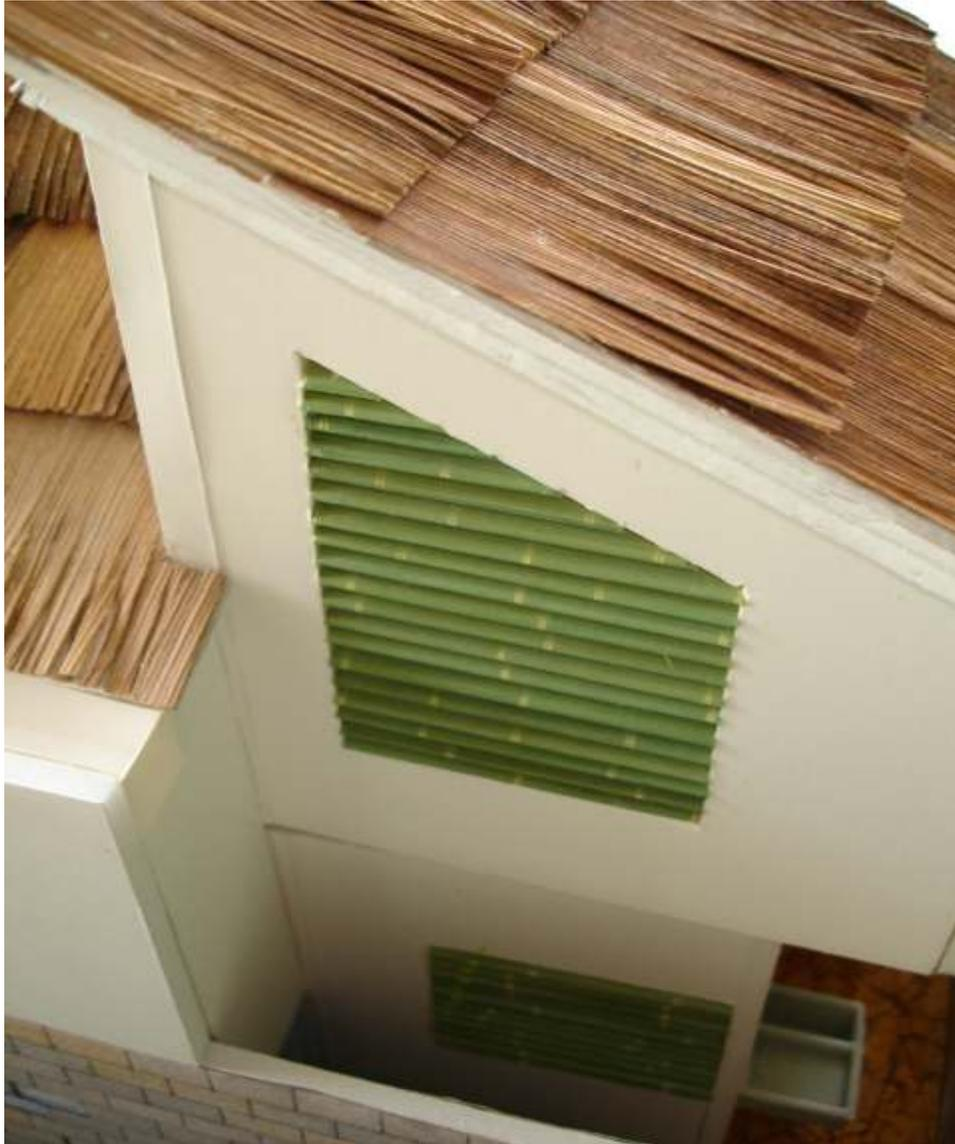
En la fachada sur se han utilizado celosías fijas de concreto prefabricado. Evitan la radiación pero permiten la circulación del aire.
