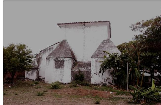
Uso de Contrafuertes para refuerzo de Paredes
