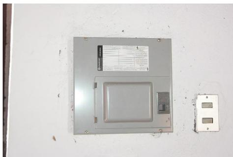
Todas las cajas y placas (Rectangulares y Octogonales) deberán ser fijadas adecuadamente y se deberá verificar que no posean ranuras que puedan permitir el ingreso de ningún tipo de insecto, con el fin de evitar que estos afecten el funcionamiento o desempeño del sistema eléctrico.
