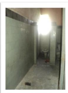
La infraestructura de las paredes cuenta con un daño causado por la filtración del agua, el daño por terremotos, el mismo que ha provocado el desgaste causando así que la pared sufra agrietamientos.
