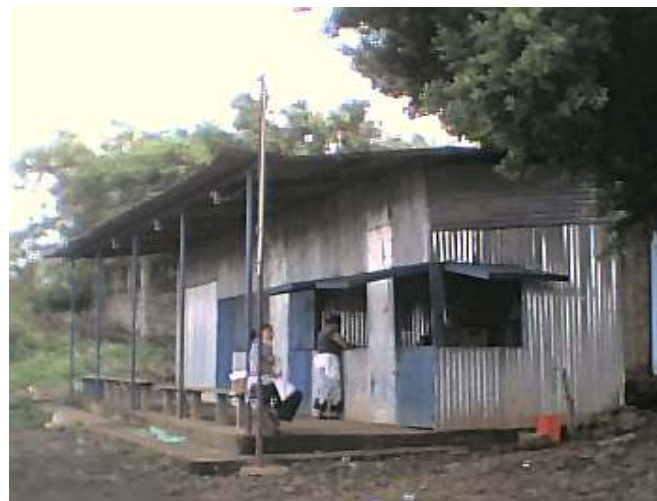
Instalaciones provisionales de la oficina administrativa
