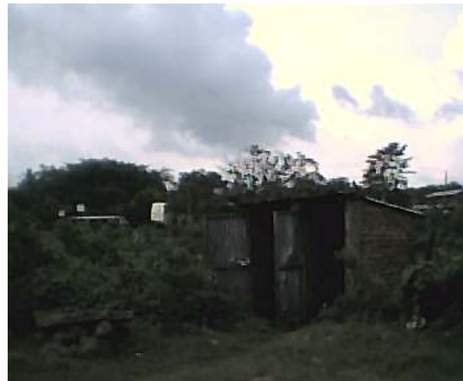
Vista de la zona de equipamiento sanitario.
