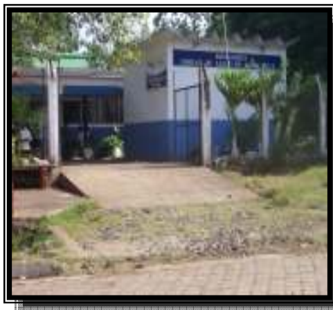
FOTOGRAFÍA N° 17 Fachada principal Unidad de Salud de la Ciudad Moncagua
