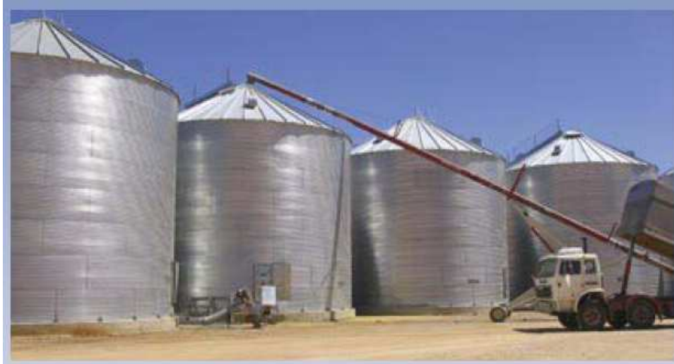
Figura 25. Transporte de materia prima desde las pilas hasta los silos de almacenamiento
