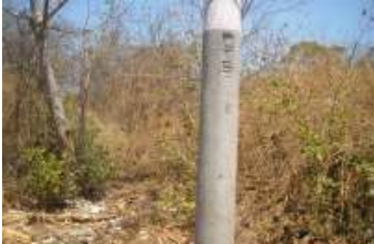
Fotografía N° 62 Servicio básicos con que cuenta el terreno
