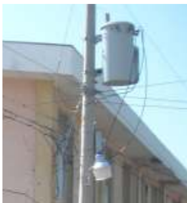
Foto N° 15 Servicios con que cuenta la ciudad de Intipuca
