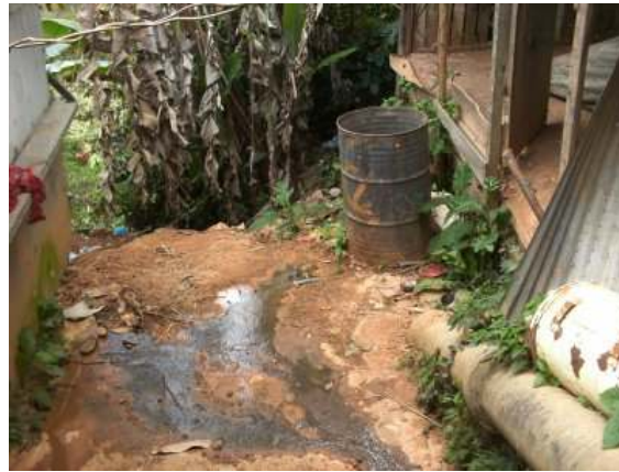
Foto N° 16 Aguas servidas que van a dar a las quebradas del municipio
