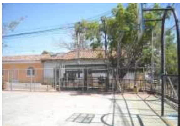
Foto N° 27 Instalación de la Cancha del Parque Municipal
