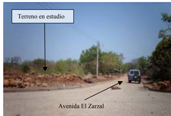
Fotografía N° 50 Lindero Poniente con Avenida El Zarzal
