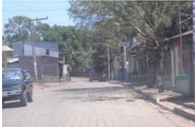
Fotografía N° 66 Estado actual de la Avenida Cámen Asturias
