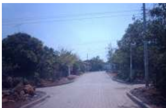
Fotografía N° 53 Intersección de Calle Los Conacastes con la Av. El Zarzal
