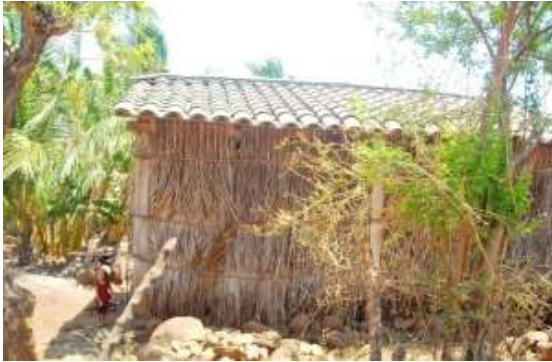
Foto N° 22 Empleo de materiales mixtos en vivienda
