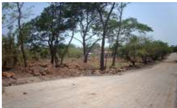
Fotografía N° 57 Estado de la Calle Los Conacastes (Poniente)
