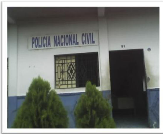
☒ Fotografía N° 25 Puesto Policial
