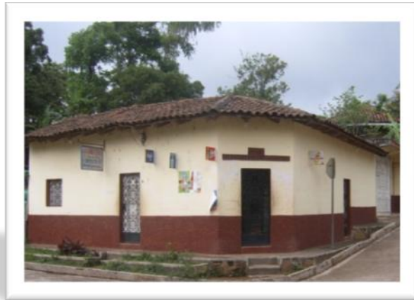
⌘ Fotografía N° 14 Fachada principal de Vivienda ubicada en Bo. La Cruz.
