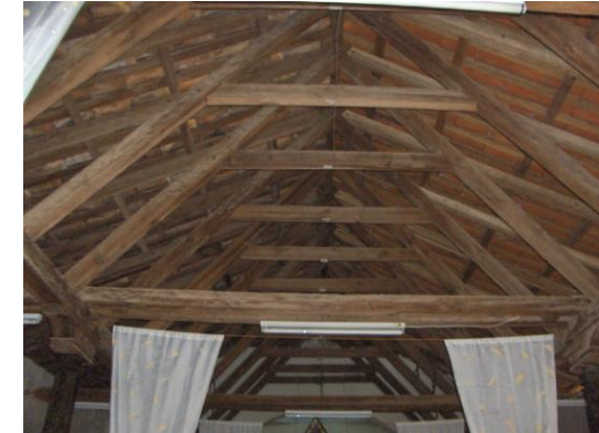
Vista de estructura de techo, iglesia de Perquin
