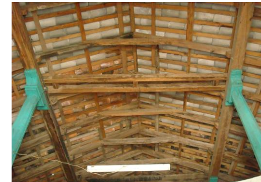
Vista de columnas y estructura de techo de madera iglesia de San Fernando
