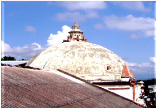
Fig. 5. Vista de la Cúpula
