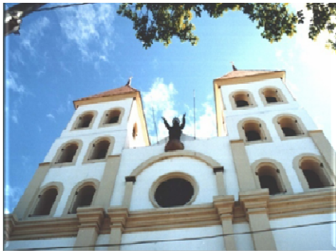
Fig. 18. Columnas o pilastras adosadas de la Fachada Principal
