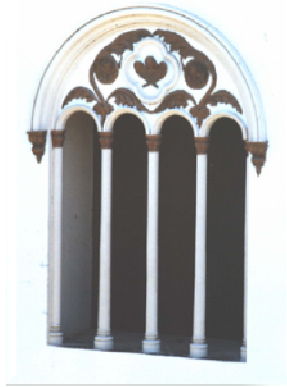
Fig. 2. Ajimez ubicado en los sectores laterales de la Fachada Principal.
