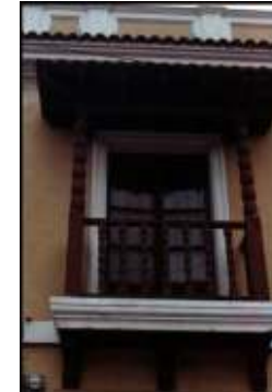
Balcón en voladizo
