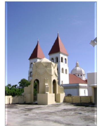
Fig. 19. Vista de la azotea, cubierta tipo losa de concreto
