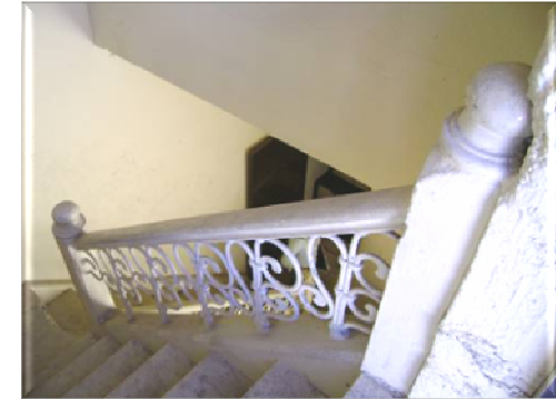
Fig. 30. Escalera que comunica a la azotea
