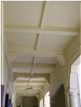
Fig. 20. Vista de las vigas que soportan la losa de entre piso
