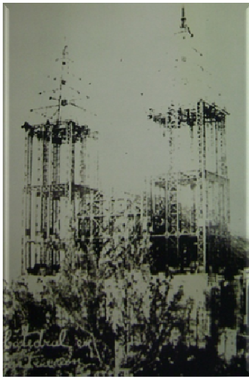
Fig. 1. Estructura metálica de las torres de la Catedral.
