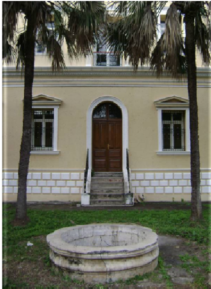
Vista exterior Fachada Posterior. Teatro Nacional "Francisco Gavidia".
