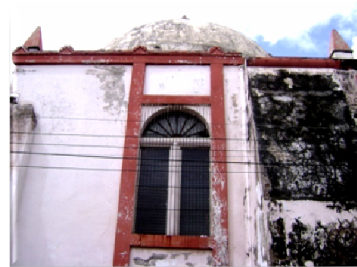
Fig. 6. Vista de la Cúpula y Contrafuerte.
