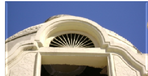
Fig. 5 Obsérvense los planos en las fachadas
