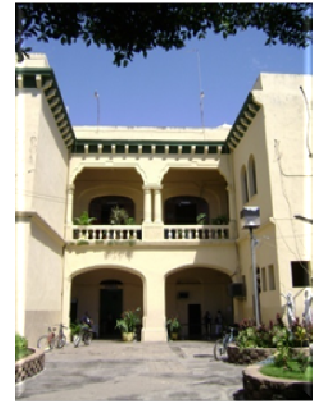
Fig. 15. Detalle de paredes del edificio
