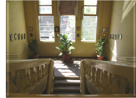
Fig. 27. Vista de las gradas tipo imperial.
