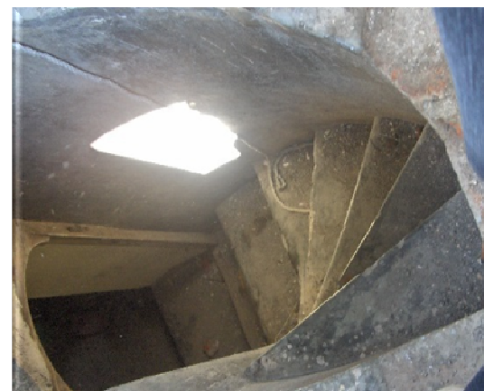
Fig. 48. Vista de Escaleras ubicadas en el Campanario.
