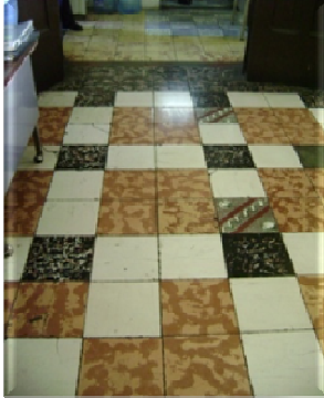
Fig. 14. Piso de ladrillo de cemento, vista del Segundo Nivel
