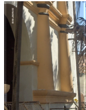
Fig. 17. Columnas adosadas de la Fachada Principal
