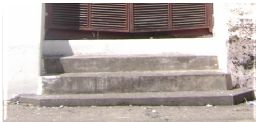
Fig. 41. Escaleras ubicadas en el acceso al Templo por el costado Este.
