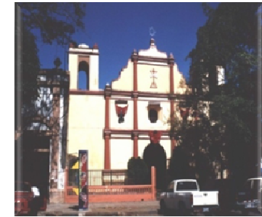
Fig. 49. Fachada Principal Sur.
