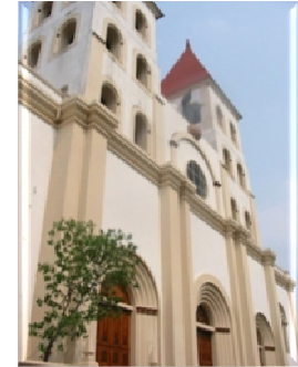
Fig. 1. Fachada Principal Oeste.
