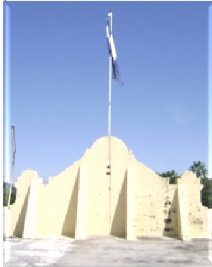
Fig. 22. Parapeto sostenido por contrafuertes
