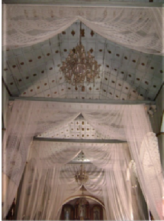
Fig. 49. Vista de Cielo Falso en la Nave Central.
