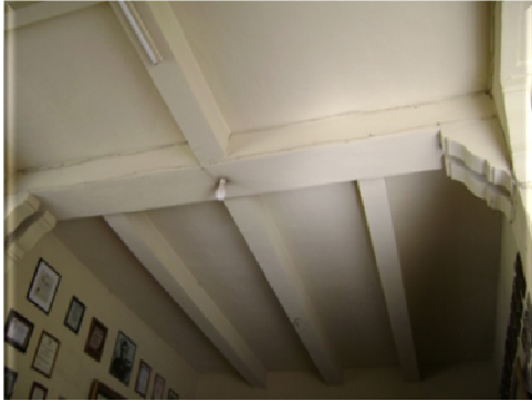
Fig. 24. Vigas que soportan la losa de la Azotea
