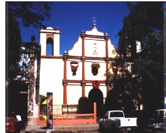
Fig. 1. Fachada Principal Sur.
