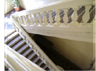
Fig. 17. Detalle de escaleras tipo Imperial
