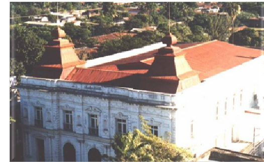
Fig. 19. Cubierta de lámina ondulada metálica y tramos de lámina de asbesto cemento.
