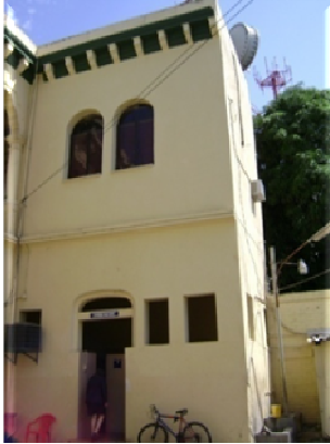
Fig. 22. Vista de las paredes del área de baños
