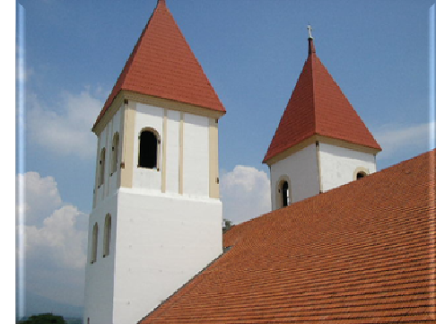
Fig. 41. La cubierta de las Naves y las torres, es lámina troquelada de zinc.
