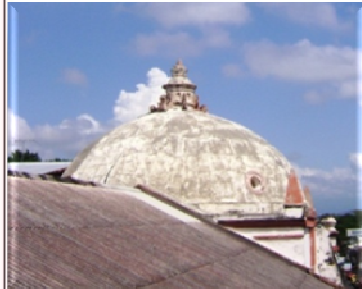
Fig. 53. Vista de la Cúpula
