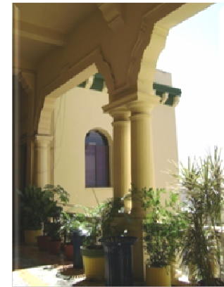
Fig. 29. Vista de columnas del segundo nivel
