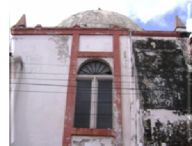
Fig. 54. Vista de la Cúpula y Contra fuerte.
