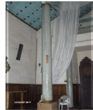
Fig. 56. Columna del interior del Templo
