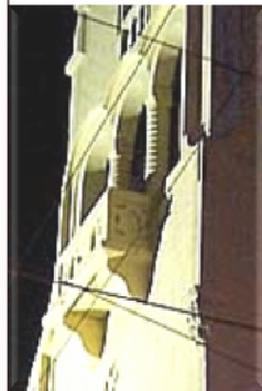
Fig. 22. Parapeto sostenido por contrafuertes
