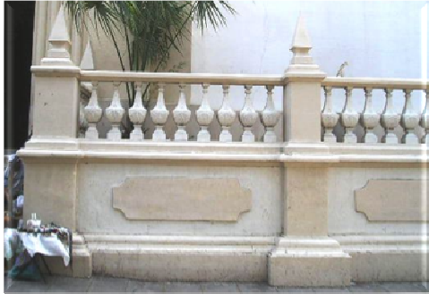
Fig. 29. Verja vista desde la Fachada Principal Poniente.
