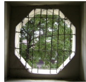
Fig. 26. Óculo en Fachada Principal visto desde el interior del Templo.
