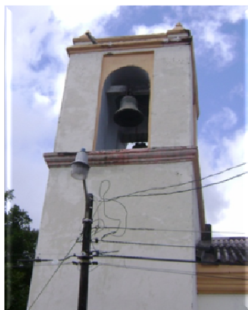
Fig. 46. Campanario con paredes de ladrillo de barro cocido.
