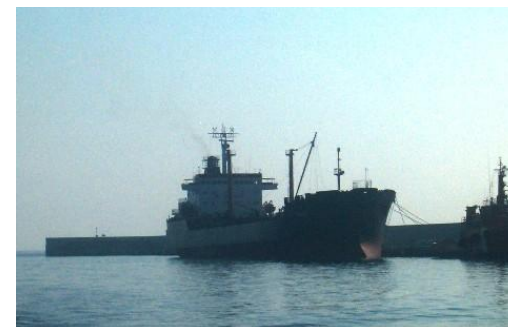
Fig. 35 Ejemplo de Instalaciones Marítimo Portuaria.
