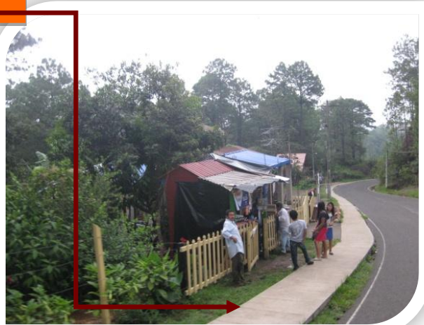
Imagen 72: Acera peatonal en vía de acceso principal CA_7 Fuente: propia
