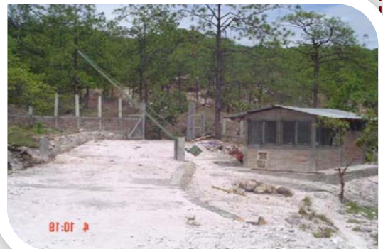
Imagen 71: Caseta de entrada donde se encuentra el relleno sanitario Fuente: tesis de relleno sanitario
