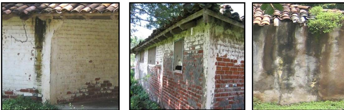
**Detalle de deterioro en paredes de ladrillo**
