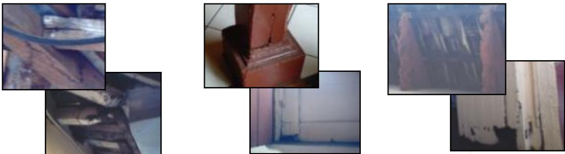
LOS DAÑOS EN LA MADERA ESTRUCTURAL PUEDEN SER OCASIONADOS POR LA INVASIÓN DE INSECTOS Y LA APARICIÓN DE HONGOS Y PUTREFACCIÓN POR LA EXPOSICIÓN A LA HUMEDAD. Y SUS EFECTOS SON APRECIABLES POR LA POLILLA Y LAS FLECHAS O PERFORACIONES EN LA SUPERFICIE DE LOS ELEMENTOS.
