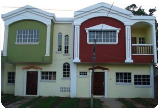
Imagen #47 Estas casas están ubicadas sobre la carretera Litoral y fueron una de las primeras viviendas de San Miguel las casas fueron hechas con adobe, después de un tiempo fueron remodeladas y hechas con bloque y detalles de tabla roca.
