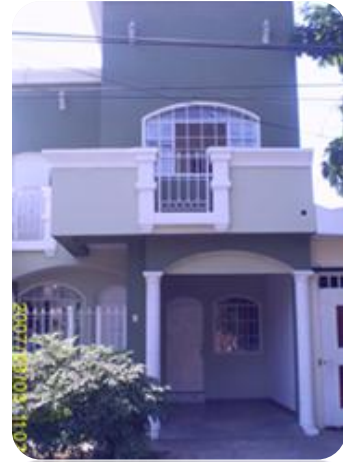
Imagen # 4 Vivienda ubicada en la Colonia Satélite de Oriente de San Miguel
