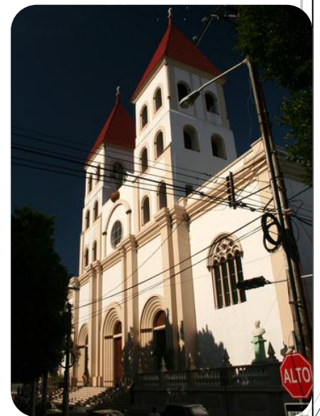
Imagen #32 Vista Exterior de la Fachada de la Catedral de San Miguel
