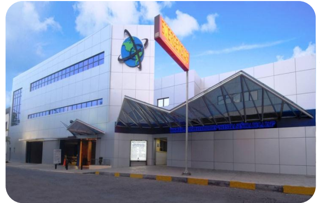
Imagen #37 Fachada Exterior del Hospital de Especialidades Nuestra Señora de la Paz, San Miguel
