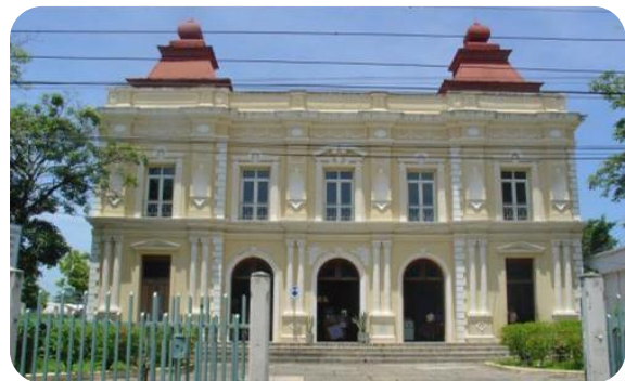
Imagen #36 Fachada del Edificio del Teatro Nacional Francisco Gavidia de la Ciudad de San Miguel.
