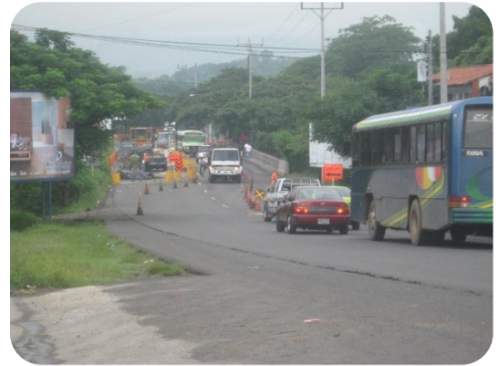
Imagen #23 Vista del Puente Urbina sobre la CA-1 de la Ciudad de San Miguel
