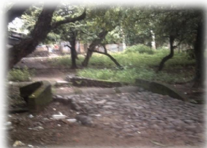
FIG. 19 PUENTE DONDE DESENOVA QUEBRADA
