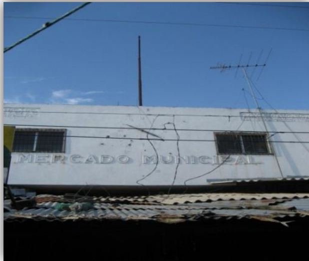
Fig.: 7 fachada principal del Mercado
