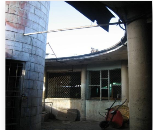
Fig.: 11 detalle de ventanas con malla ciclón
