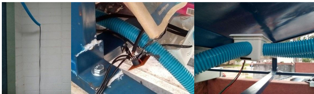
Figura 60: Instalación de cableado. (2018). [Fotografía]. Fuente: Los autores.
