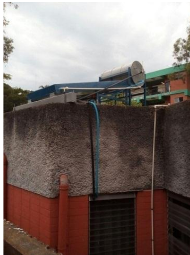
Figura 66: Instalación del equipo en la clínica. (2018). [Fotografía]. Fuente: Los autores.
