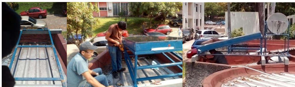
Figura 58: Montaje de las estructuras. (2018). [Fotografía]. Fuente: Los autores.
