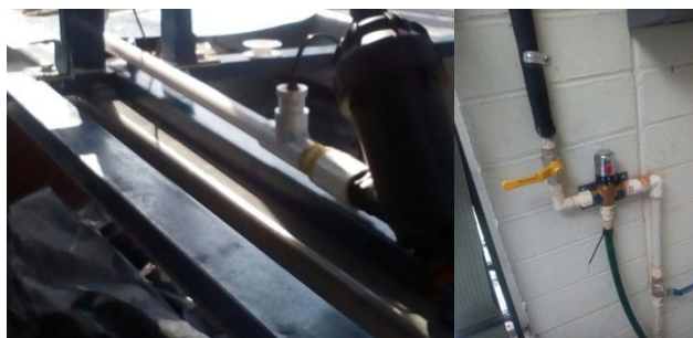
Figura 59: Instalación de tuberías y accesorios. (2018). [Fotografía]. Fuente: Los autores.
