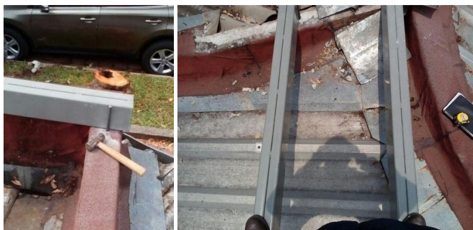
Figura 57: Instalación de los polines de soporte. (2018). [Fotografía]. Fuente: Los autores.
