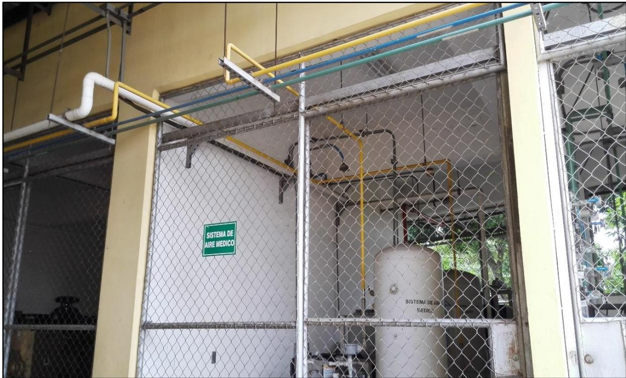
*Imagen 3.40: Tuberías de gases medicinales ancladas aéreamente, de color amarillo Aire Médico, en color blanco tubería de vacío, en color verde Oxígeno y en color azul Óxido Nitroso.*
