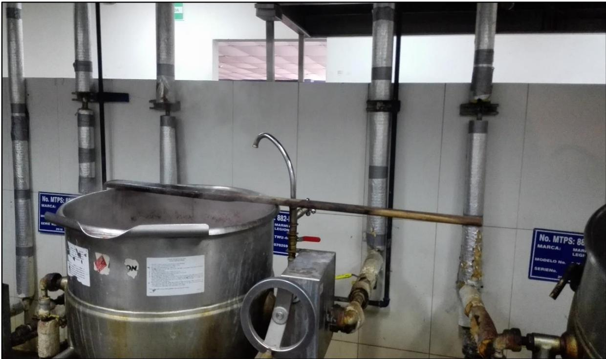
*Imagen 3.43: Tuberías de vapor llegando a cocina.*
