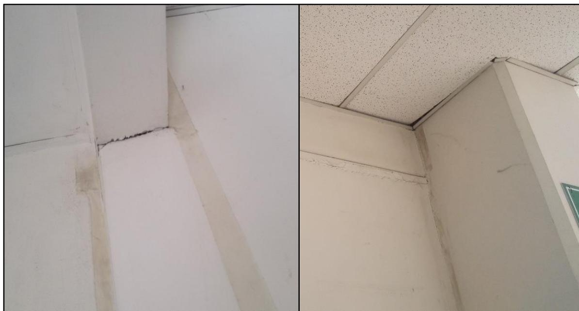
*Imagen 3.12: Deterioro en las uniones entre columna y división de tabla roca.*
