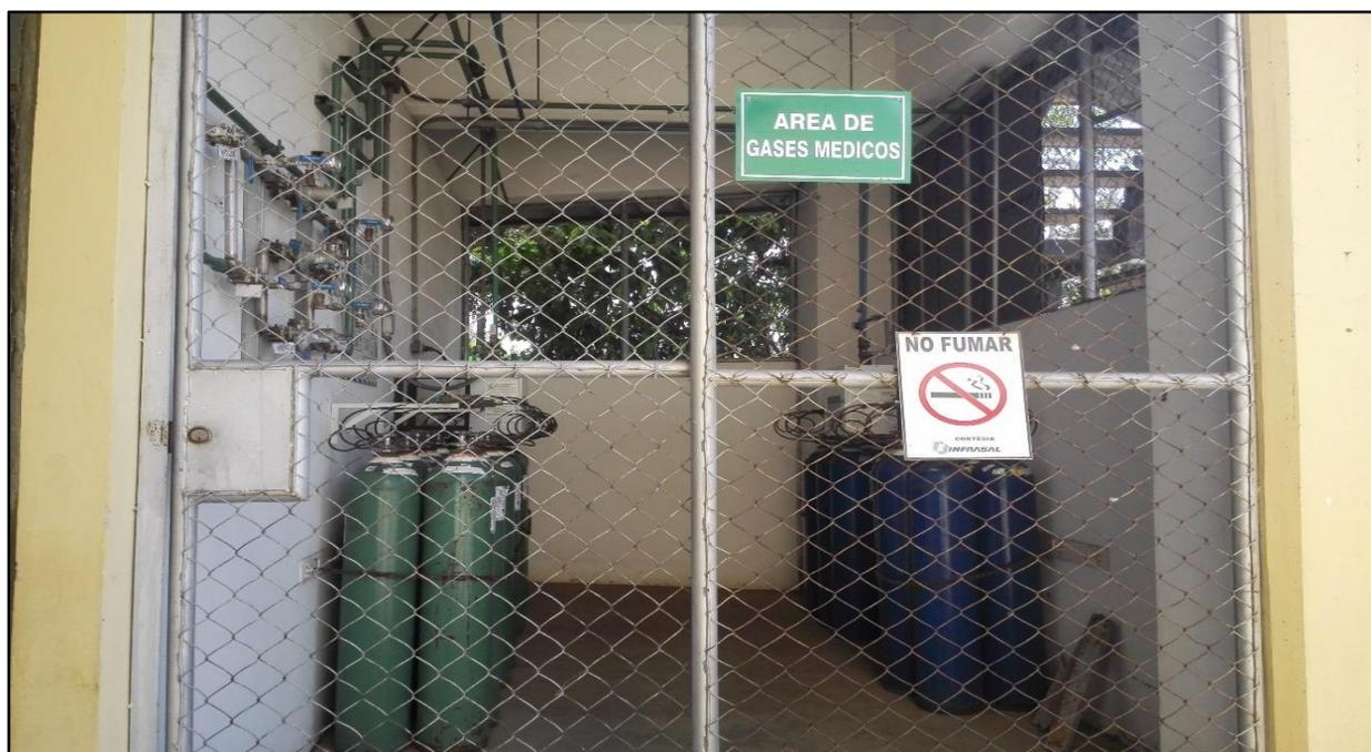
*Imagen 3.38: Sistema de cilindros de gases médicos, en color verde Oxígeno y en color azul Óxido Nitroso.*
