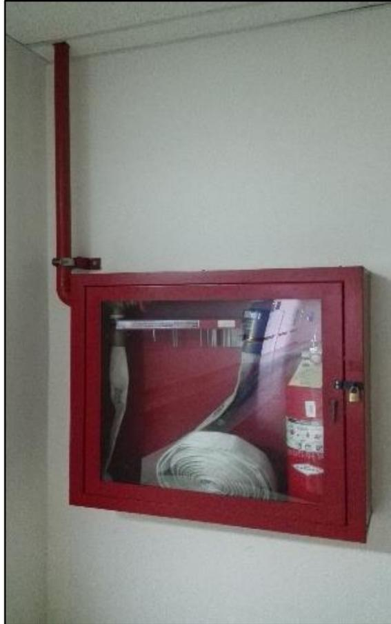
*Imagen 3.79: Gabinete contra incendios sin señalización y desactualizado en su recarga, ubicado en el cuarto nivel de la torre de hospitalización.*
