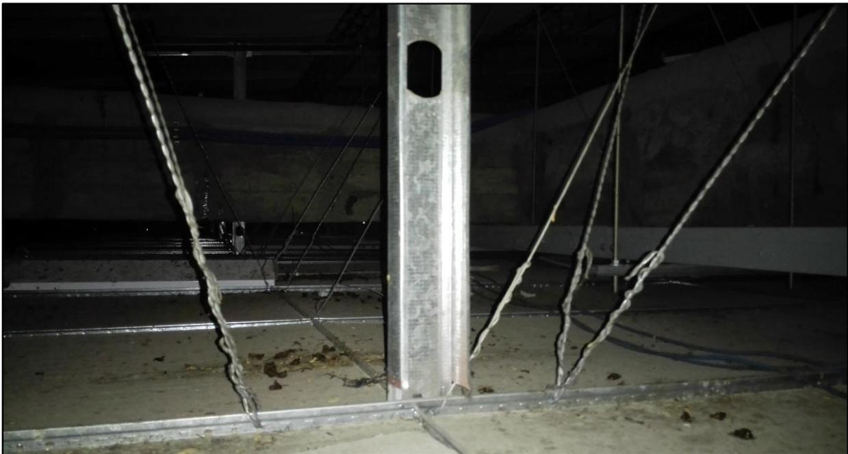
***Imagen 3.76: Sistema de soporte del cielo falso, alambres para sujeción lateral y sujetador de aluminio a la compresión.***
