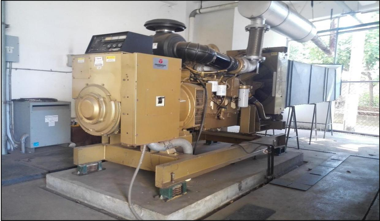
***Imagen 3.17: Generador 1 modelo TRADEWINDS TJ250 con una capacidad de 250KW ubicado en casa de máquinas.***
