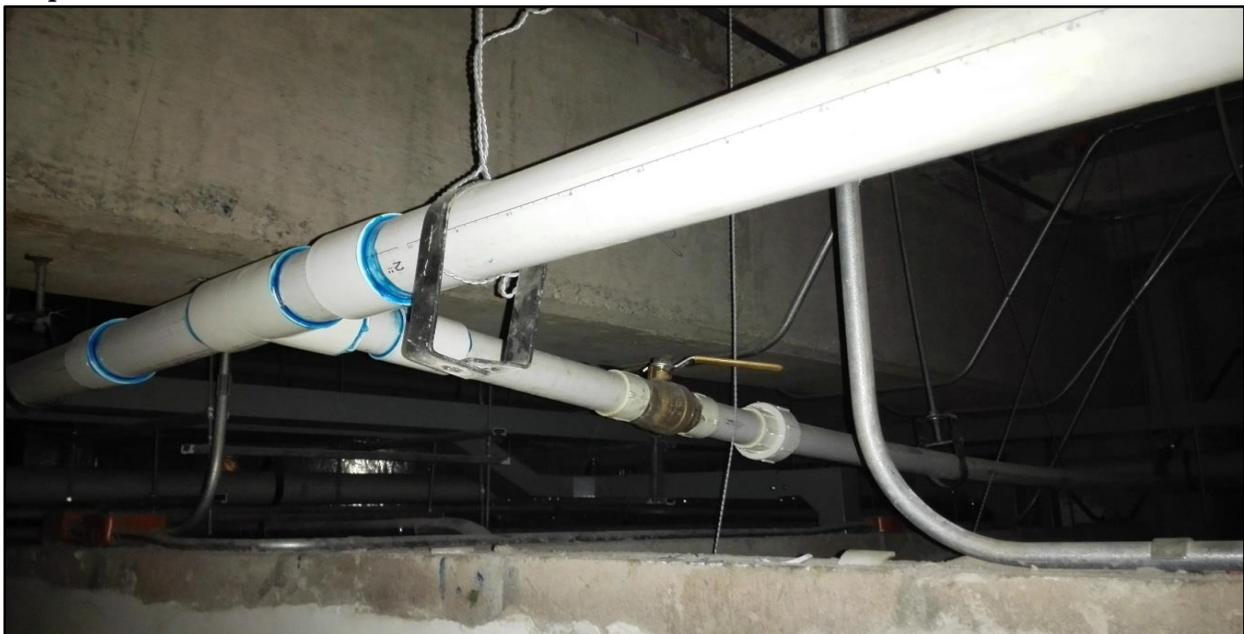
***Imagen 3.31: Tubería de agua potable en el interior del edificio de hospitalización.***
