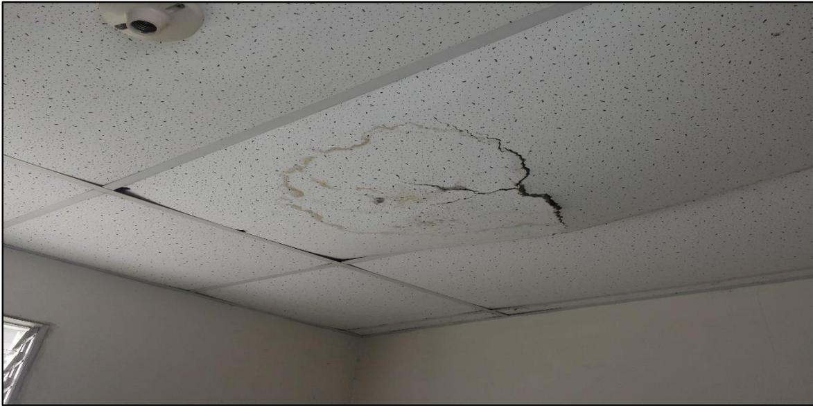
*Imagen 3.77: Daño de loseta de cielo falso debido a humedad.*
