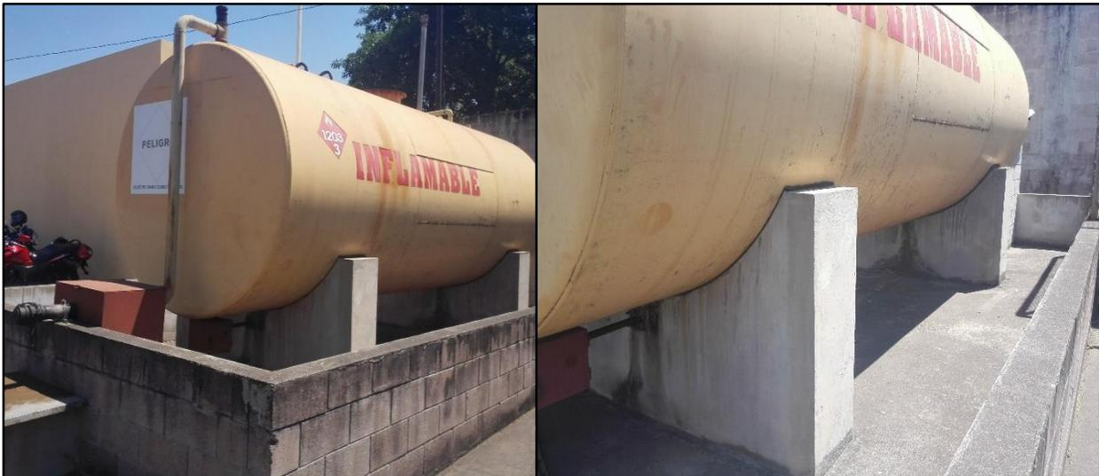
*Imagen 3.33: Muro perimetral y durmientes de apoyo del tanque de diésel del hospital.*
