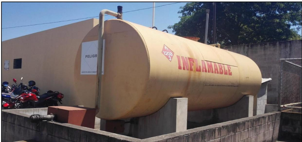
***Imagen 3.32: Tanque de diésel con capacidad de 5000 galones, ubicado al costado Sur del hospital.***
