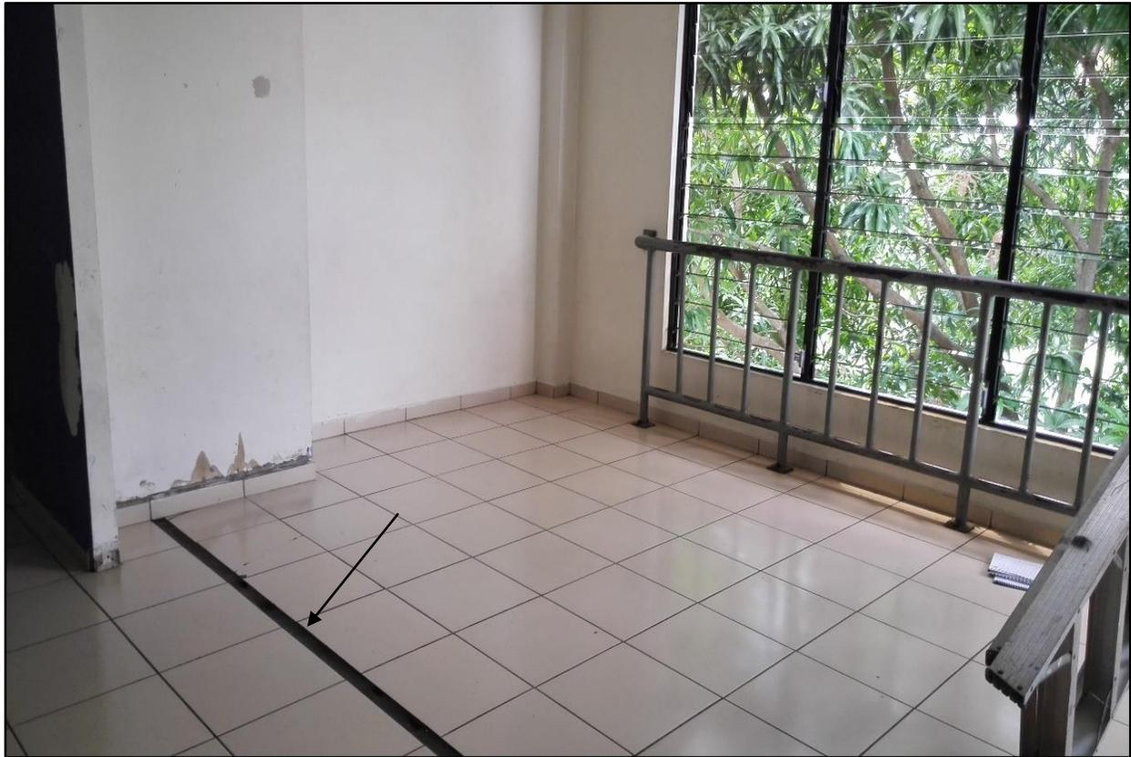
*Imagen 3.10: Ampliación al costado Este de la torre de consulta externa, sobre el piso en color negro se ubica la junta de dilatación. Las escaleras de emergencia se encuentran a la derecha del espacio mostrado.*
