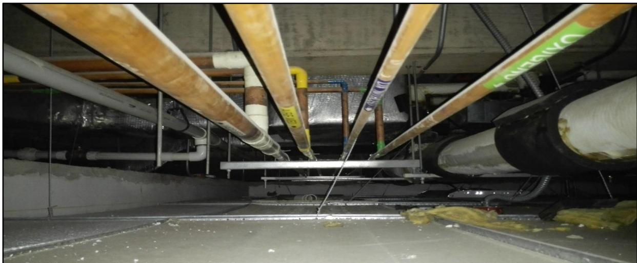
*Imagen 3.41: Vista de tuberías de gases medicinales dentro del edificio de hospitalización sobre el cielo falso.*
