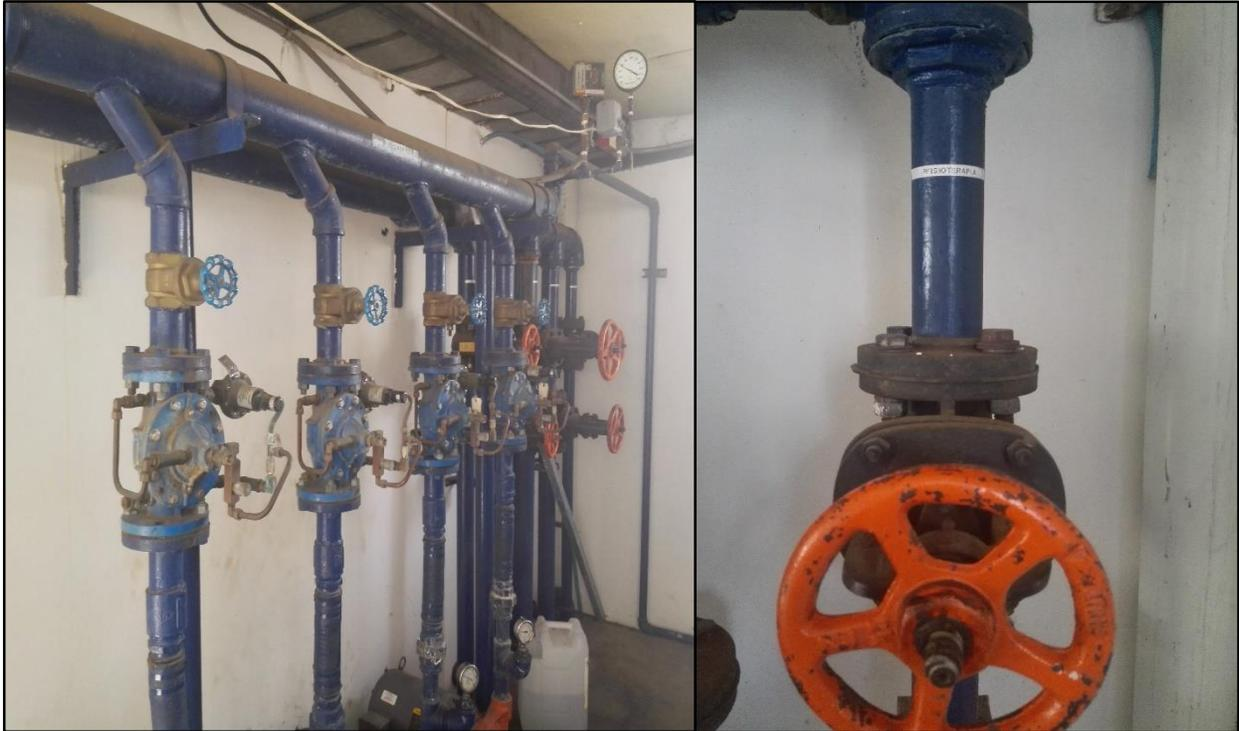
***Imagen 3.30: Red de tuberías de distribución de agua potable hacia las diferentes áreas del hospital.***
