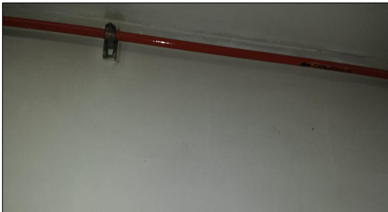
*Imagen 3.36: Tubería de gas propano anclada en la parte superior de una pared, dirigida hacia cocina.*
