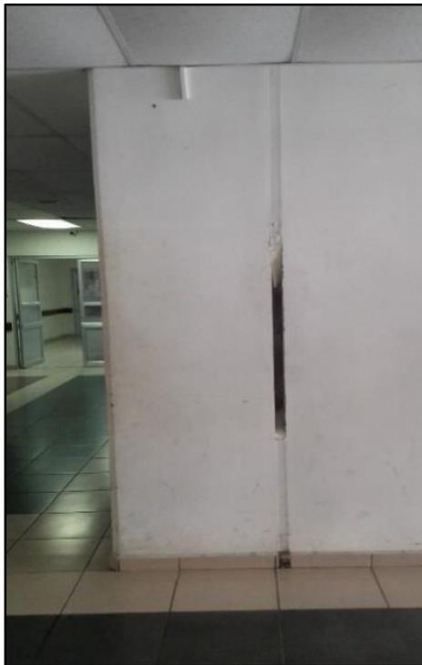
***Imagen 3.13: Junta de dilatación entre columna y pared de mampostería de block, edificio de Hospitalización.***
