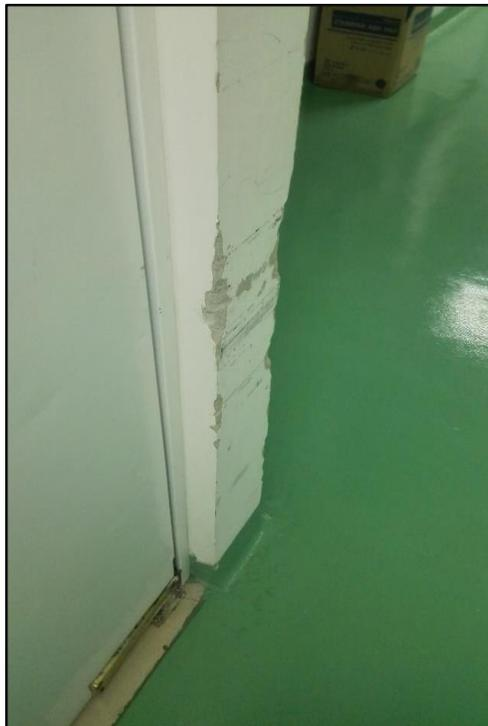
*Imagen 3.11: Deterioro en una pared sobre el área de circulación interna de cirugía debido a la circulación de camillas.*
