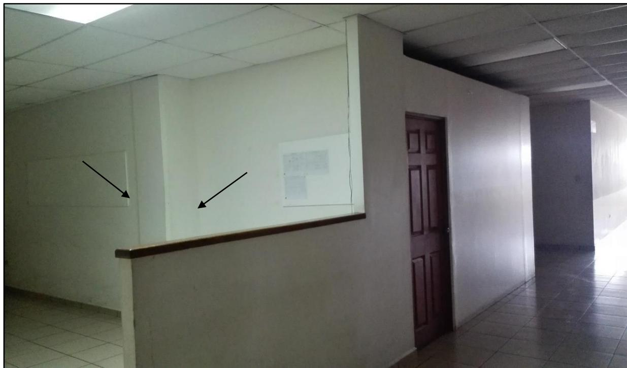
***Imagen 3.14: Divisiones de tabla roca ligados a una columna por medio de juntas de dilatación. Cuarto nivel torre de hospitalización.***
