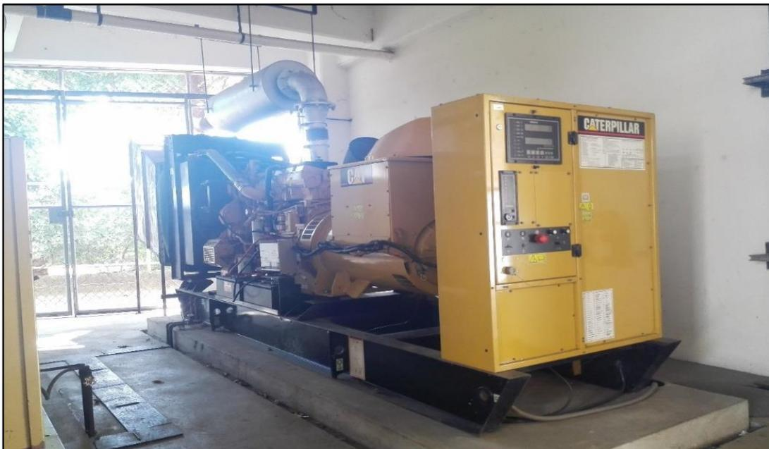
***Imagen 3.18: Generador 2 modelo CATERPILLAR LC6 con una capacidad de 500KW, ubicado en casa de máquinas.***
