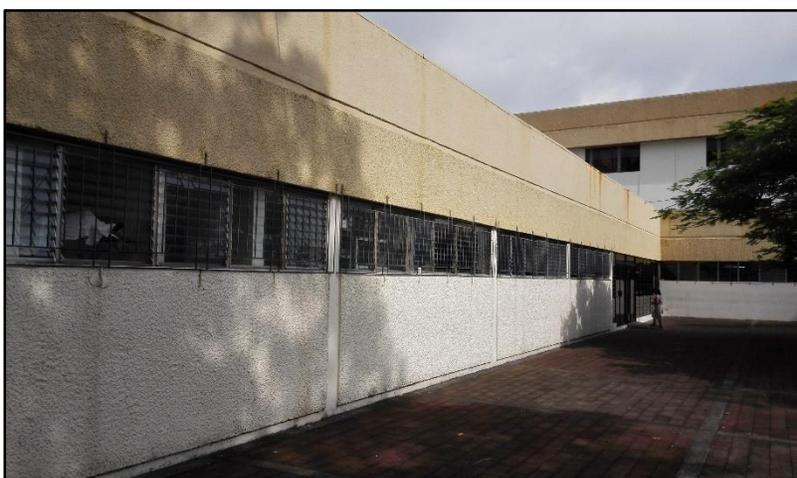
*Imagen 3.65: Ventanas de celosía de vidrio protegidas con balcón metálico. Ala de consulta externa.*
