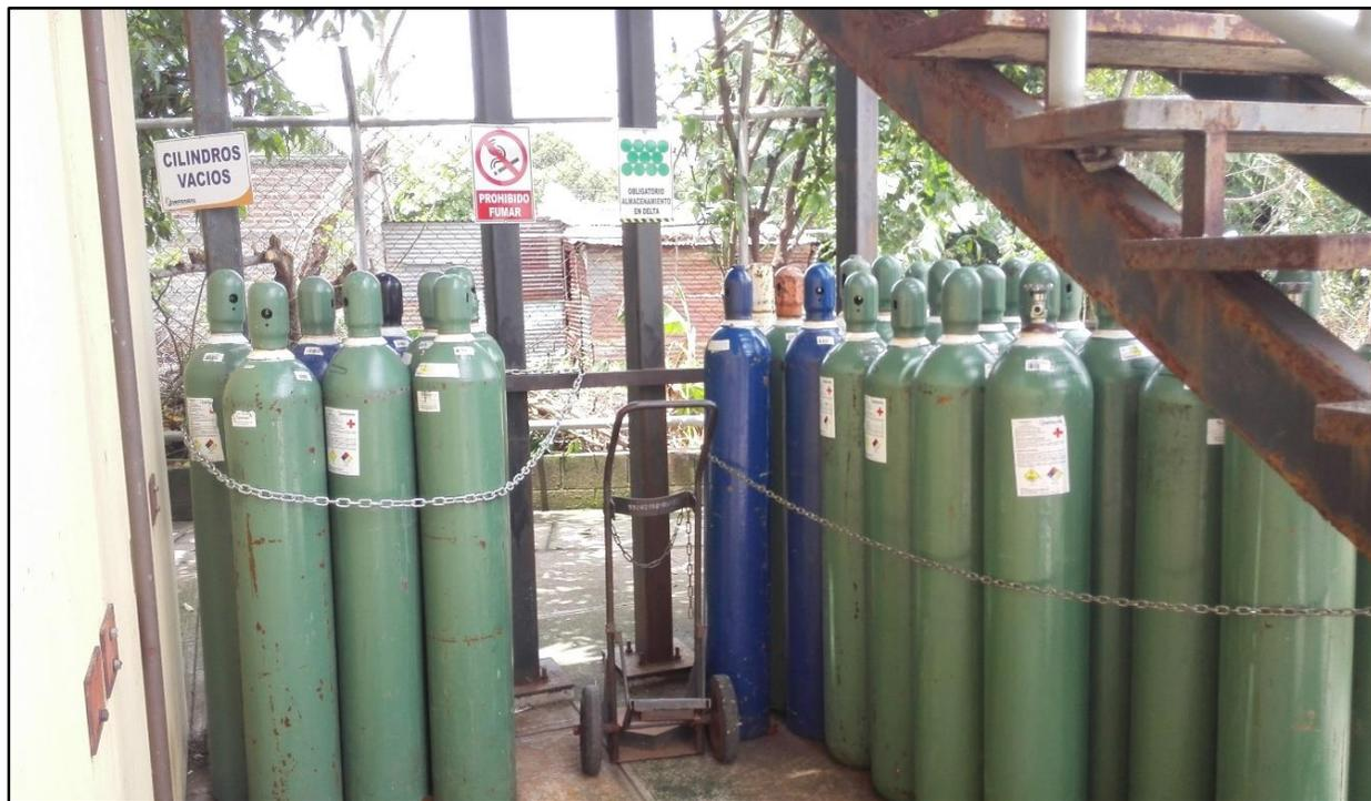
***Imagen 3.39: Sistema de reserva de gases medicinales, en verde Oxígeno y en azul Óxido Nitroso.***
