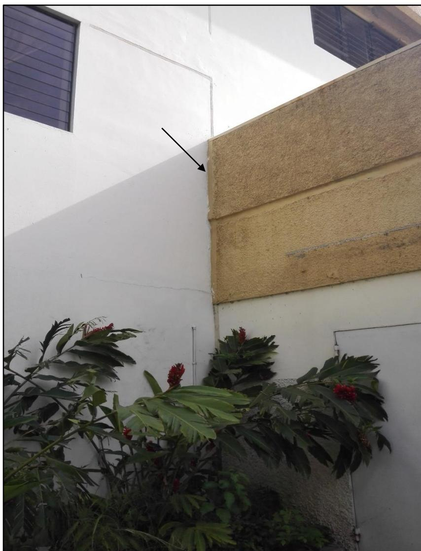
*Imagen 3.67: Parte del muro de cierre de la torre de consulta externa y la unión con el ala de un nivel mediante juntas de dilatación.*
