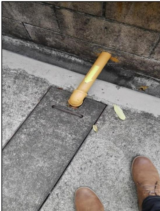
*Imagen 3.35: Tubería de distribución de diésel dirigida de forma subterránea hacia el área de calderas.*
