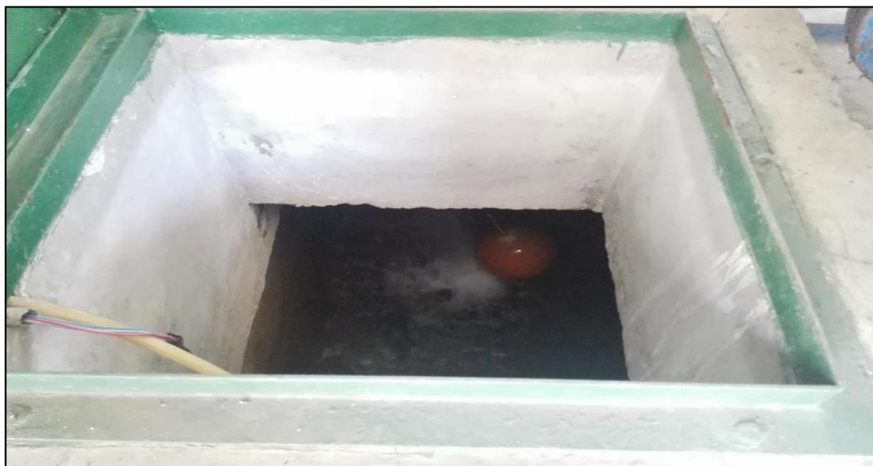
**Imagen 3.28: Sistema de flotador para cerrar el paso de agua de la tubería de ANDA cuando la cisterna se encuentra llena.**
