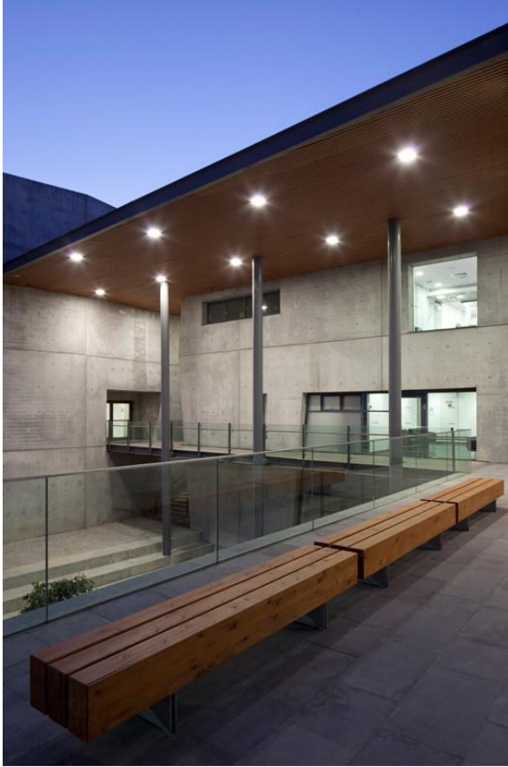
Figura 36: Vista de pasillos exteriores
