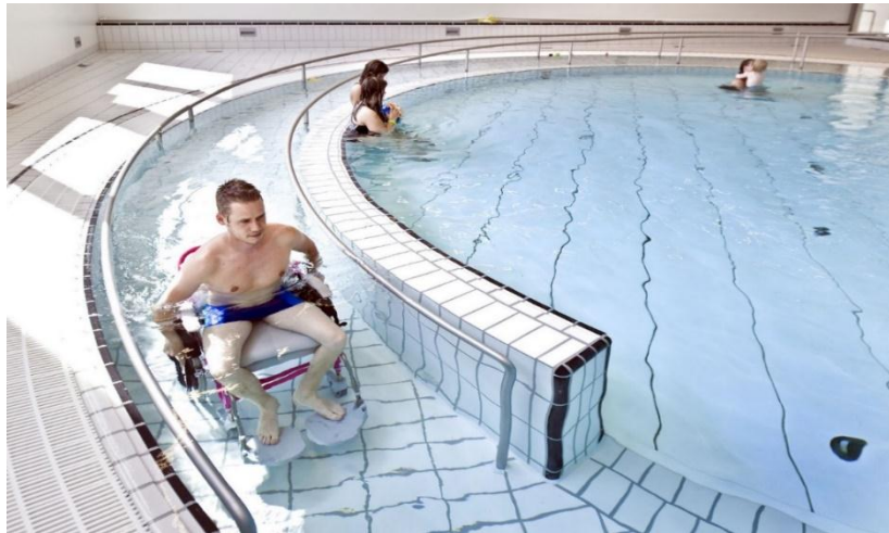
Figura 32 Rampa de acceso a piscina de hidroterapia,
