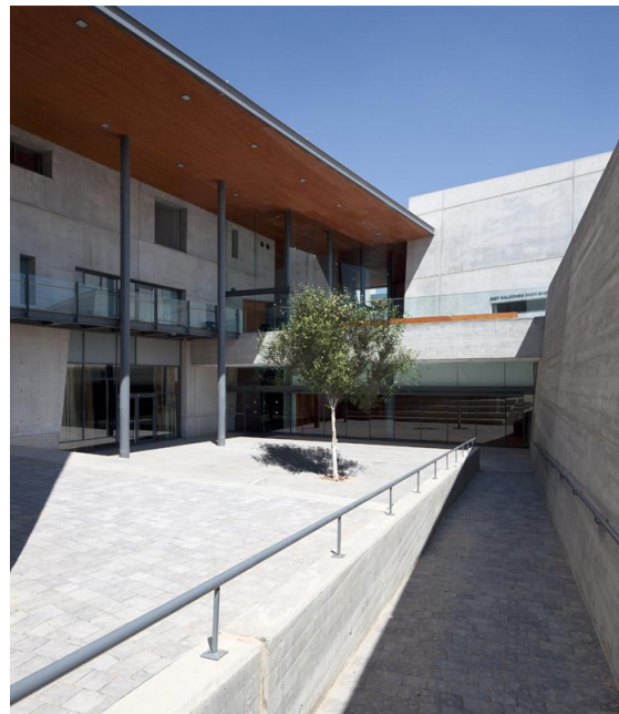
Figura 35 Rampa de acceso para personas discapacitadas
