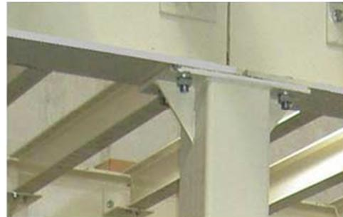
Figura 4.31. Unión entre columna y viga de acero por medio se placas, pernos y ángulos.
