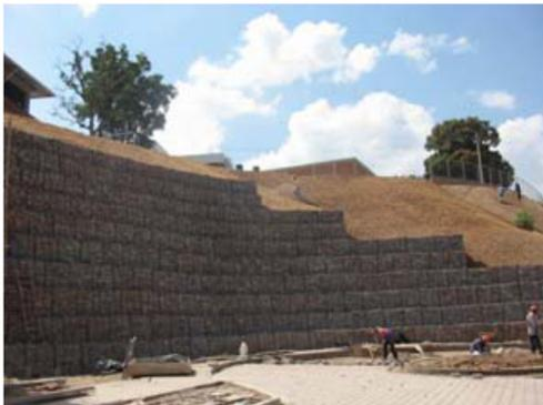
Figura 4.28. Muros gaviones construidos en fundación Padre Arrupe, Soyapango.
