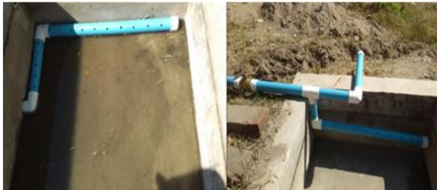
Figura 14. Instalación de tuberías para el sistema de flujo sub superficial y válvula para regular caudal de entrada.
