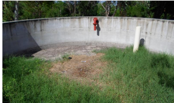
Figura 8. Digestor de lodos de la PTAR de San Luis Talpa.
