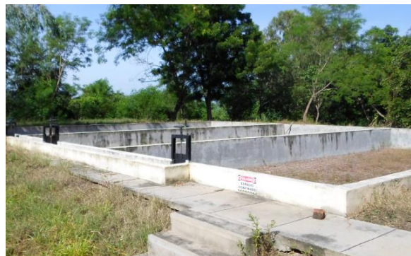
Figura 9. Patios de secado de la PTAR de San Luis Talpa.
