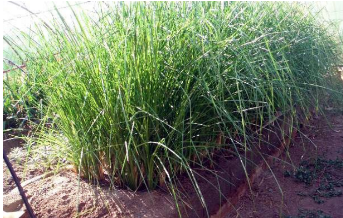
Figura 1. Filtro biológico de la PTAR de San Luis Talpa.
