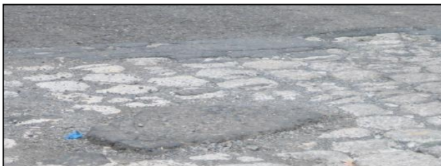
La figura 53: “Reparación de bache”
