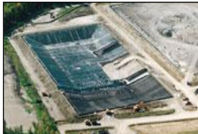
“Fotografías del Relleno Sanitario en su fase de construcción”
