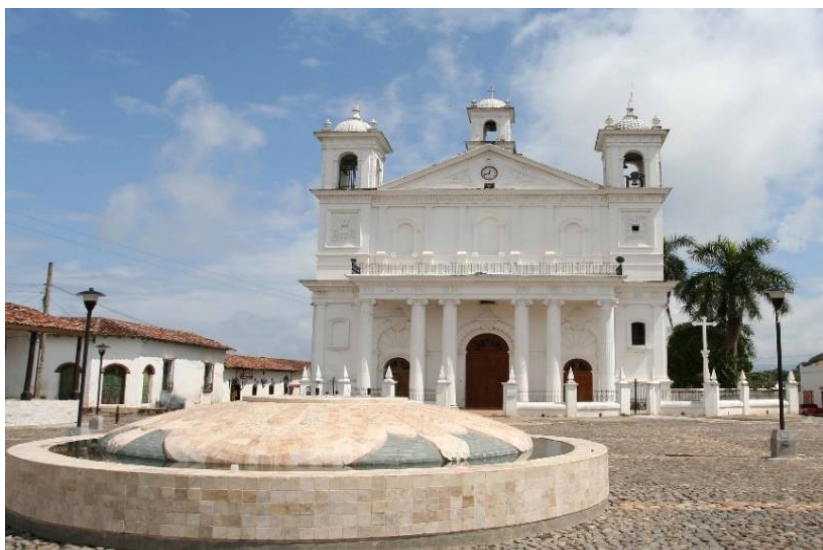
Fotografía 8. Fachada de la iglesia de Suchitoto, Cuscatlán, El Salvador.
