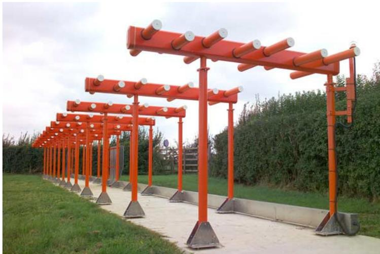
Figura 5. Instalaciones de antenas para Sistema de Aterrizaje por instrumentos.
