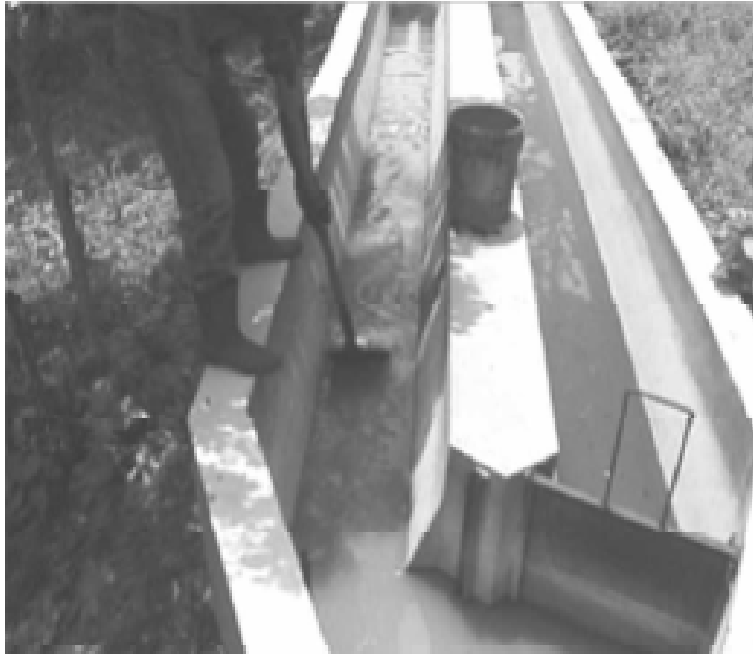
Fig. 6.5.2 Limpieza del Desarenador.
