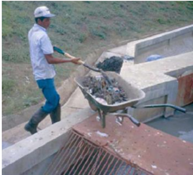
Figura. 6.5.1 Limpieza de rejillas
