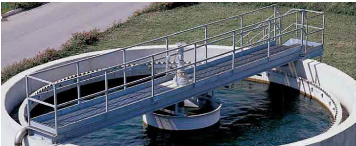
Fig. 6.5.4 Sedimentador primario. Fuente: www.goole.com.sv
