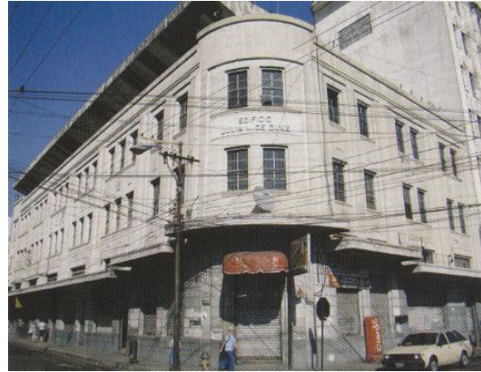
Edificio Julia L. de Duke, finales de la década de 1940. Calle de la Amargura, sector poniente.
