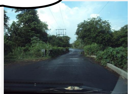
Calle hacia Montegrande, donde se observa el puente de la Quebrada el Jute.
