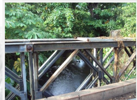
Puente de la Quebrada el Jute.
