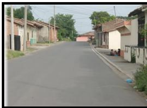
Foto N° 35 vías de acceso con recubrimiento hidráulico
