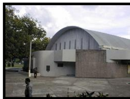
Foto N° 7 Sede central Santa Tecla
