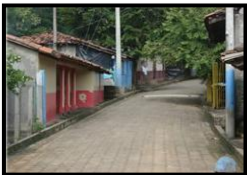
Foto N° 34 vías de acceso con recubrimiento adoquinado
