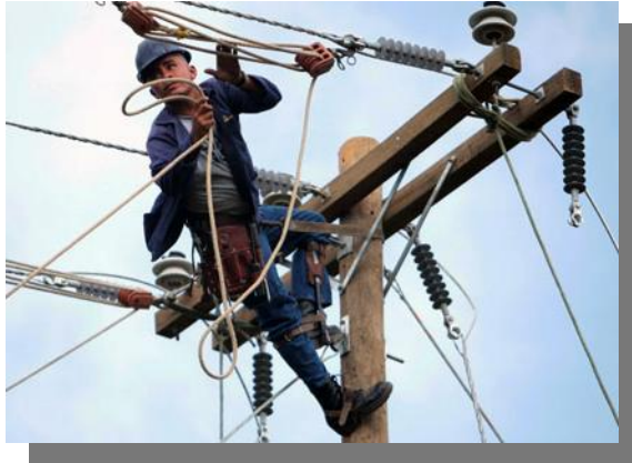
Fig. 24 Suministro de Energía Eléctrica
