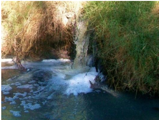
Fig. 23 Desagüe de Aguas Negras
