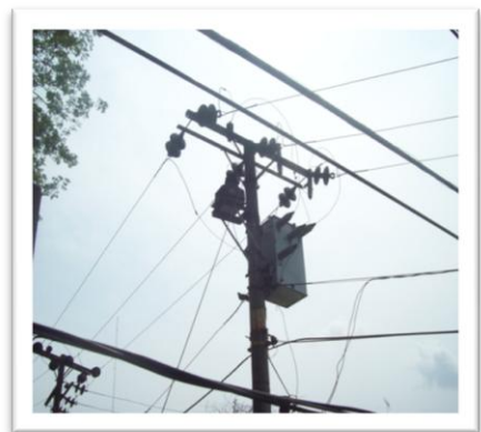
Fig. 35 Contaminación visual Dentro del hospital.
