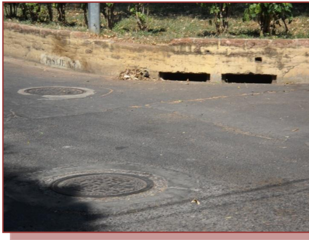
Fig. 21. Pozos de aguas.
