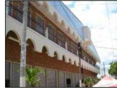
Fotografía Nº 16 Mercado Municipal del municipio de La Unión.
