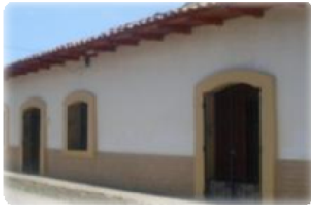
Fotografía Nº 69 Vivienda Colonial restaurada.
