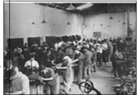
TALLER DE LA ESCUELA DE INGENIERIA MECANICA Y ELECTRICA.
