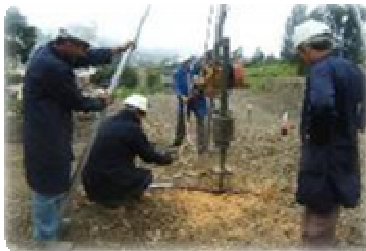
Fotografía N° 34 Prueba y muestra de Suelos.
