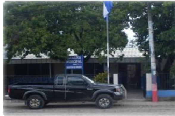
Fotografía Nº 73 Alcaldía Municipal de Concepción de Oriente Ubicada en el barrio el Centro.
