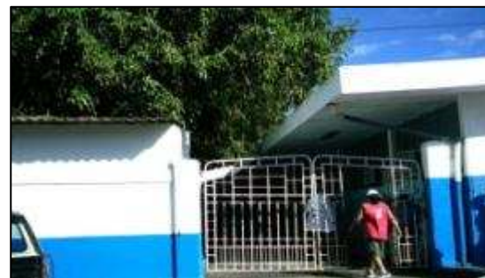
Fotografía Nº 18 Hospital Nacional del municipio de La Unión.
