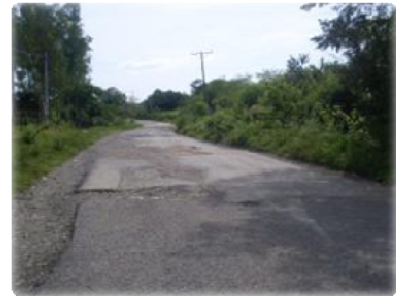
Fotografía N° 26 Calle principal de acceso a la Villa de Concepción de Oriente.
