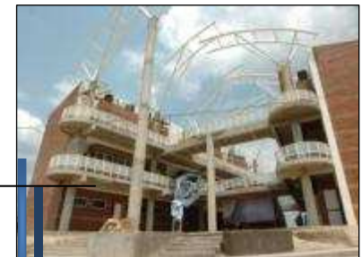
Fotografía N° 11 Fachada principal en proceso de construcción.
