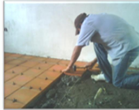
Colocación de Ladrillos
