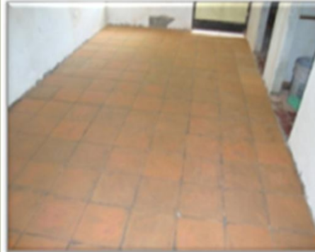
Piso después de Lijado para emparejar
