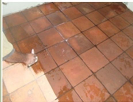
Piso después de Lijado para emparejar
