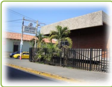
Imagen 88. Construcción con Concreto.
