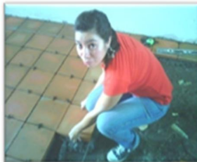
Colocación y Nivelación
