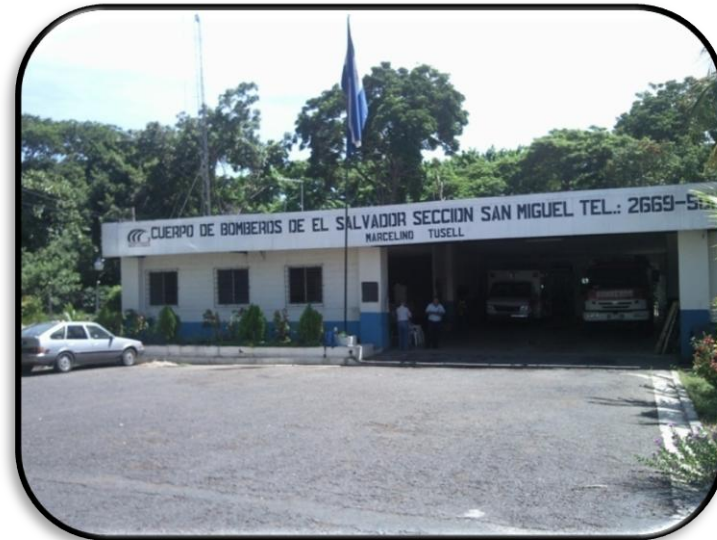
Acceso Área de Maquinas
