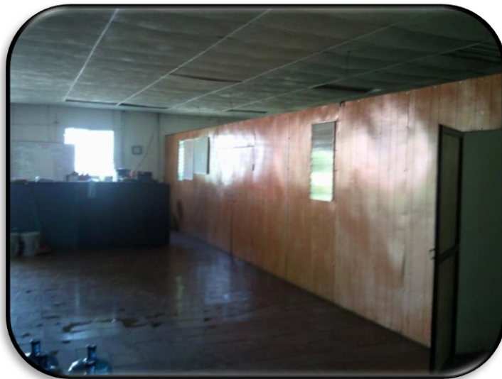
Acceso a dormitorios
